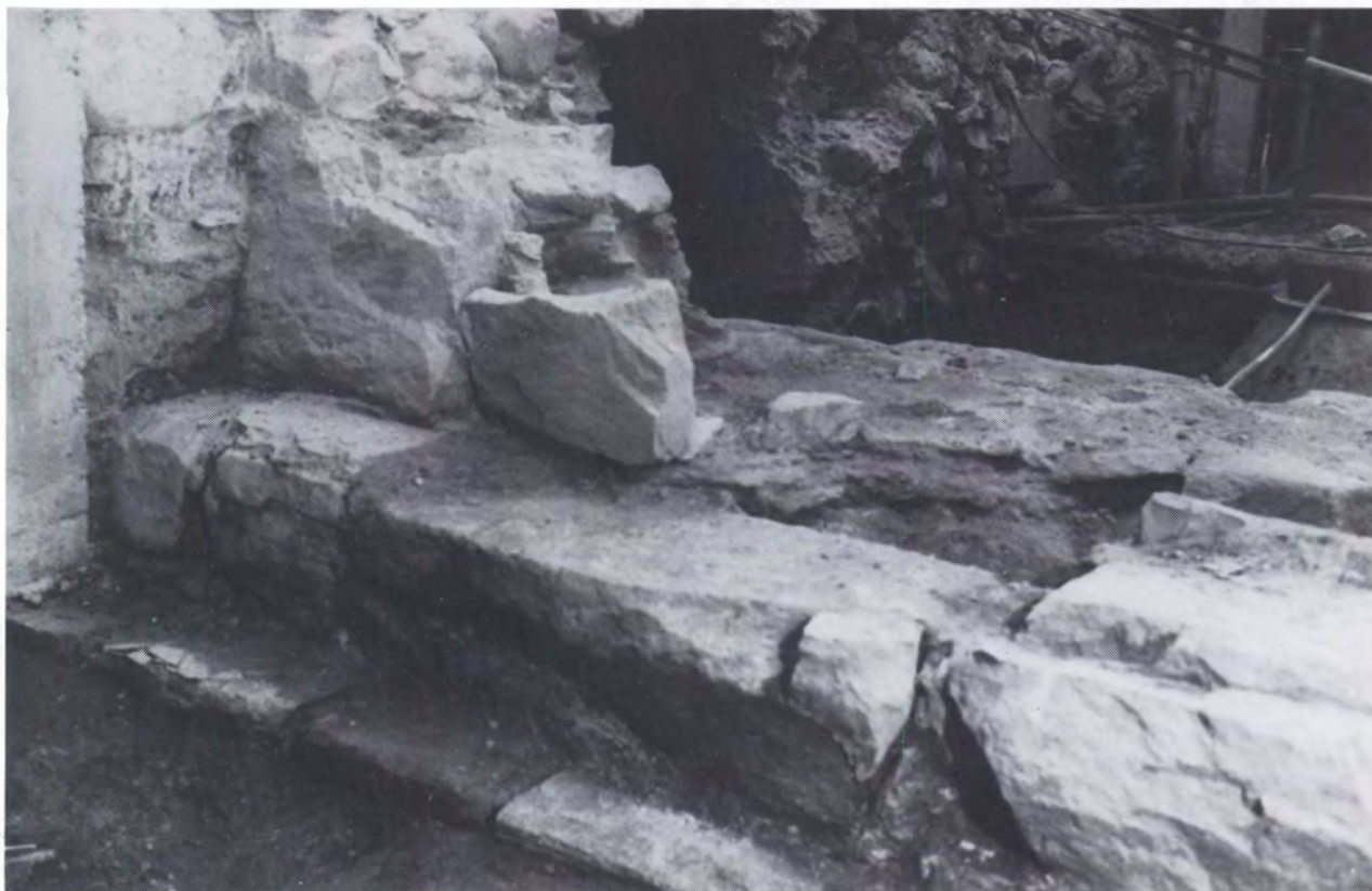
Fig. 34 Foto av innvendig nordvegg i skipet med veggbenk. Sett mot nordvest.
