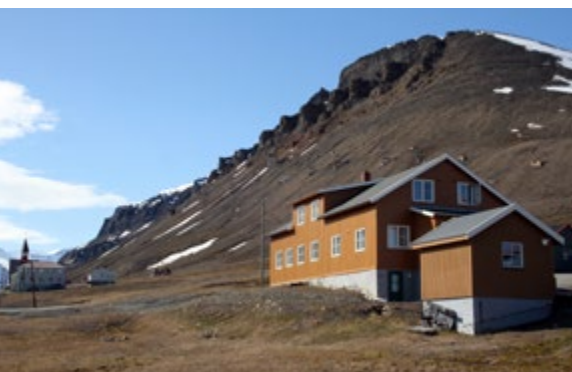
↑ Bergmesterboligen. Den gamle bergmesterboligen ble bygget i 1931. Foto: Siri Wolland, Riksantikvaren
