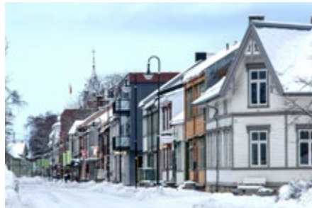
Trehusa i Levanger er frå den korte perioden mellom bygningsloven av 1896 og murtvangsloven av 1904. Foto: Trond Hattrem, Hattrem AS
