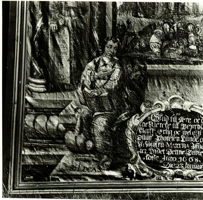
Nedre venstre hjørne, for restaurering.
