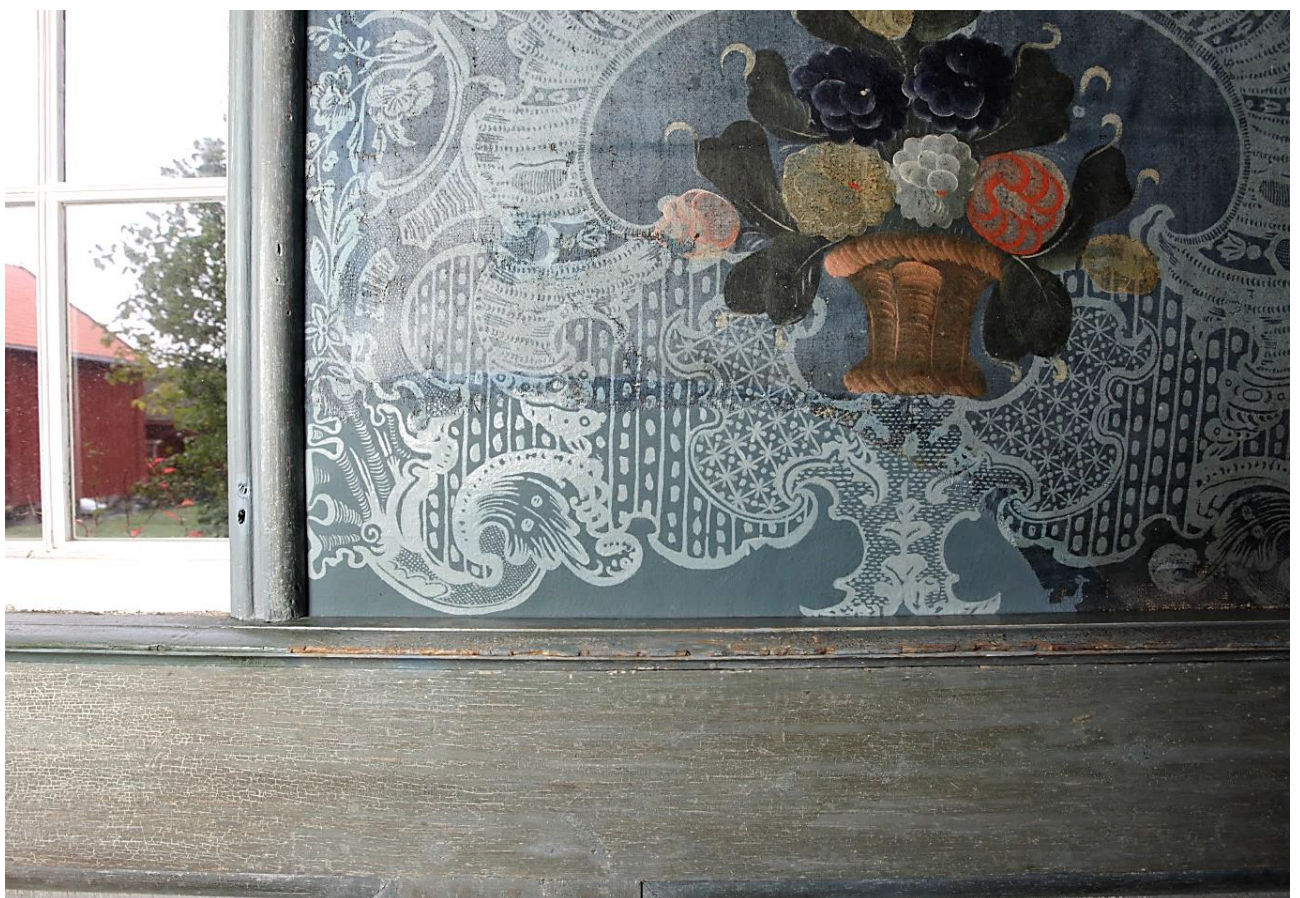
Figur 56. Samme område etter behandling. Skaden er reparert med en ny lapp hvor motivet er rekonstruert.
