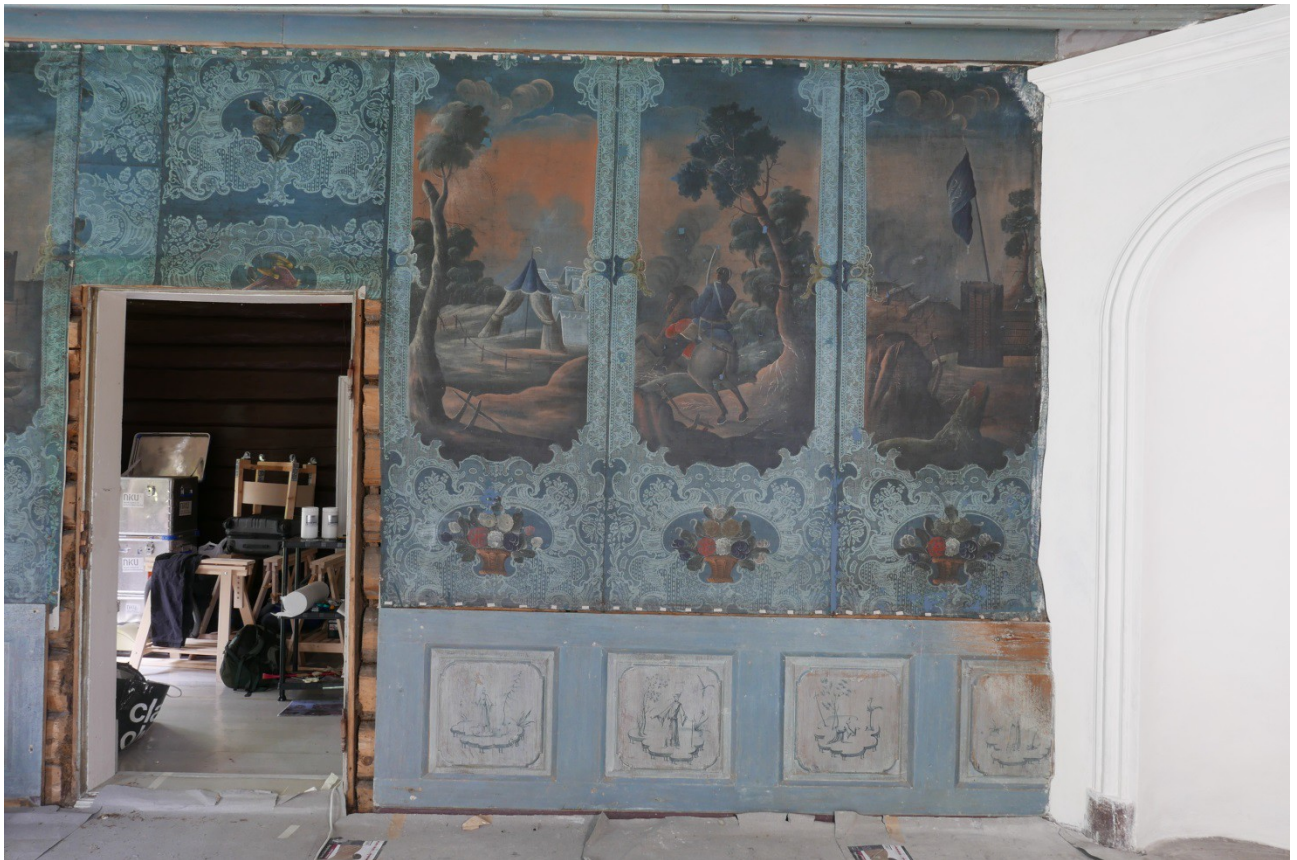
Figur 60. Østre del av nordveggen, før montering av listverket. Stifteklemmene ble festet gjennom et tykt papir for å beskytte tapetoverflaten.
