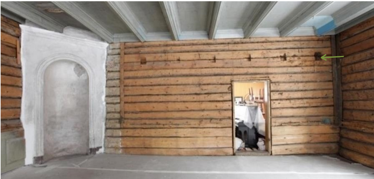
Figur 42. Østveggen, etter demonstreringen av lerretstapet og brystningen. De uthugde sporene er etter et lavere bjelketak
