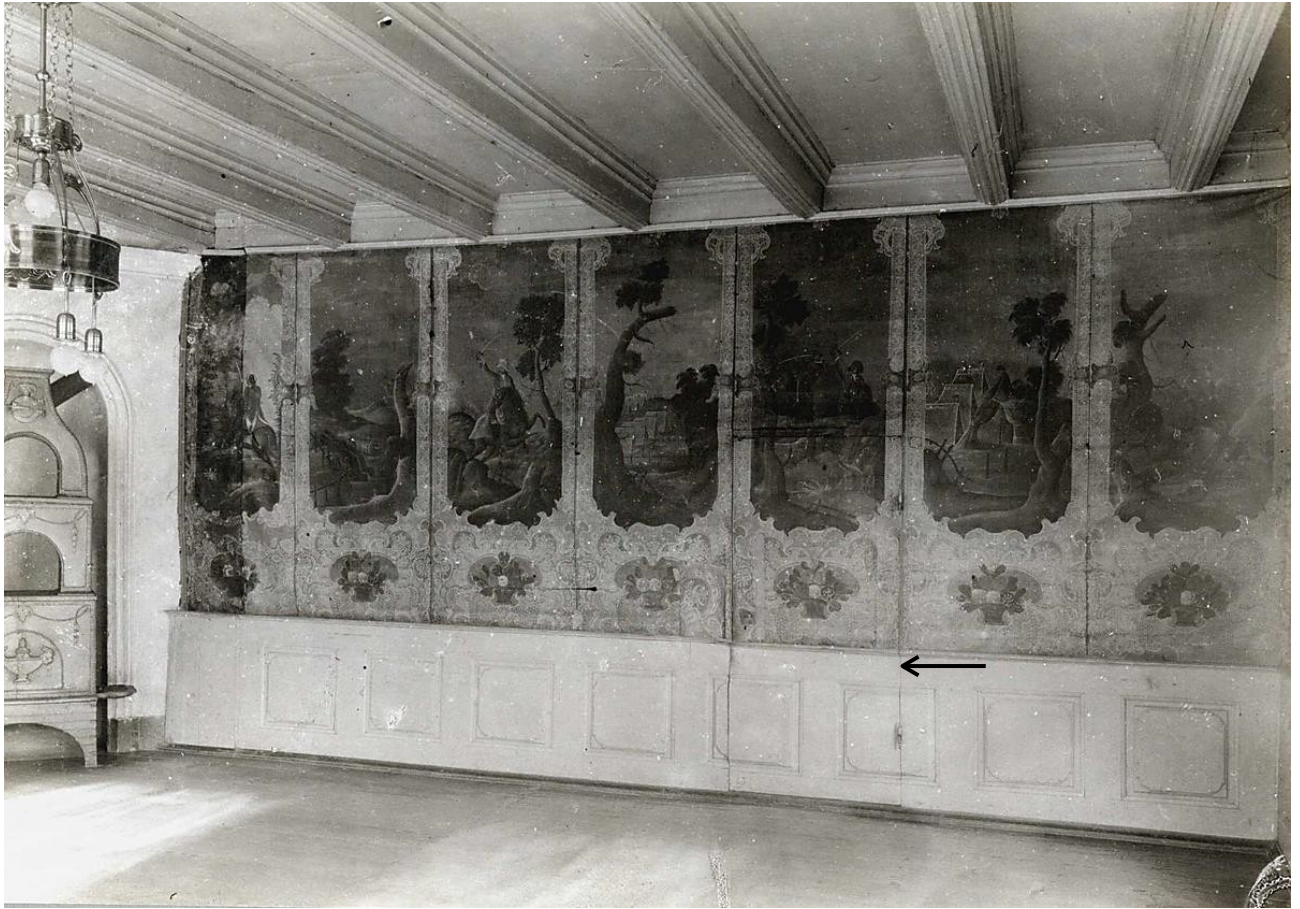
Figur 19. Blinddøren på østveggen er dekket av tapet og brystning. Arkivbilde av østveggen fra 1923.
