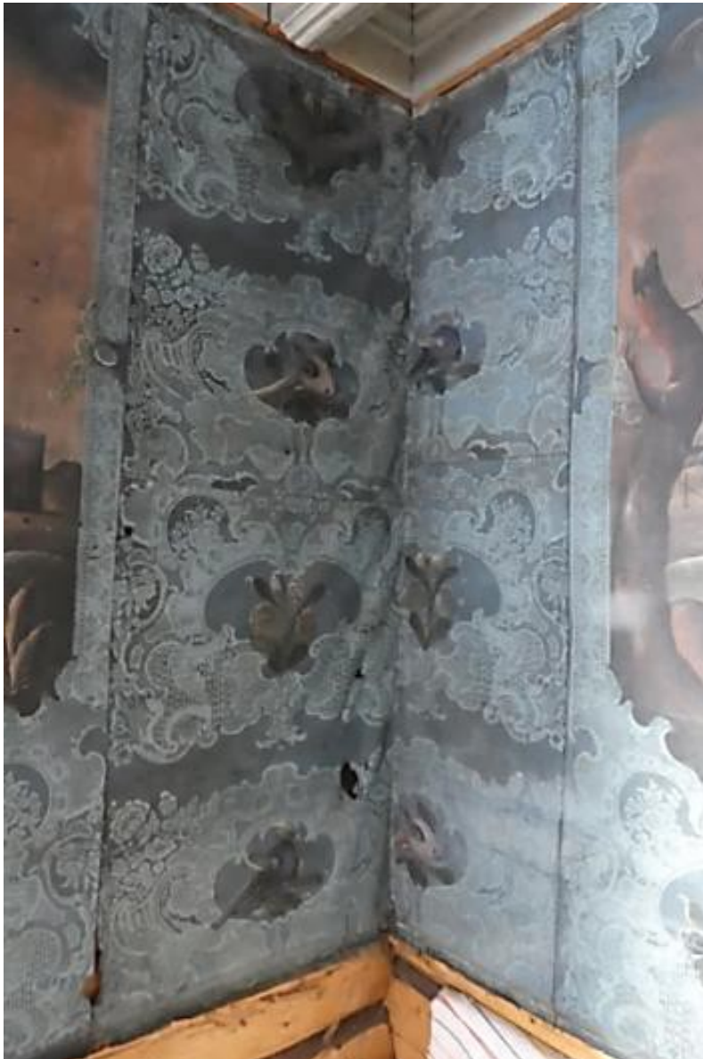
Figur 16. Tapetbanene i nordvestre hjørne og over vinduene på syd- og vestveggen har fugle- og blomsterbuketter som motiv. Begge banene er skjøtet horisontalt på midten.
