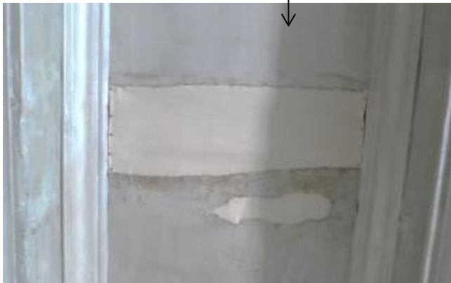
Figur 47. Lappene erstattet av nye, før oppmaling.
