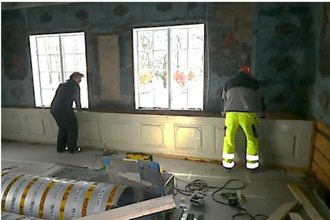
Figur 40. Demontering av brystningen. Brystningene på syd- og vestveggen var i hele veggens lengde med skjøt midt på. De var tappet sammen uten lim. På bildet blir delene dratt fra hverandre.
