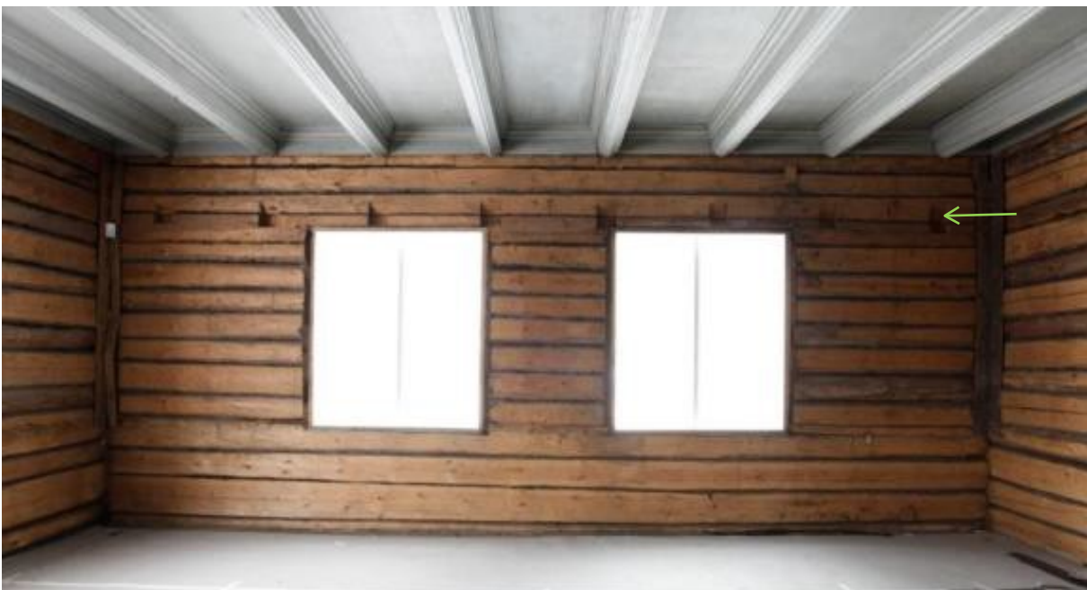
Figur 43. Vestveggen med spor etter et lavere bjelketak
