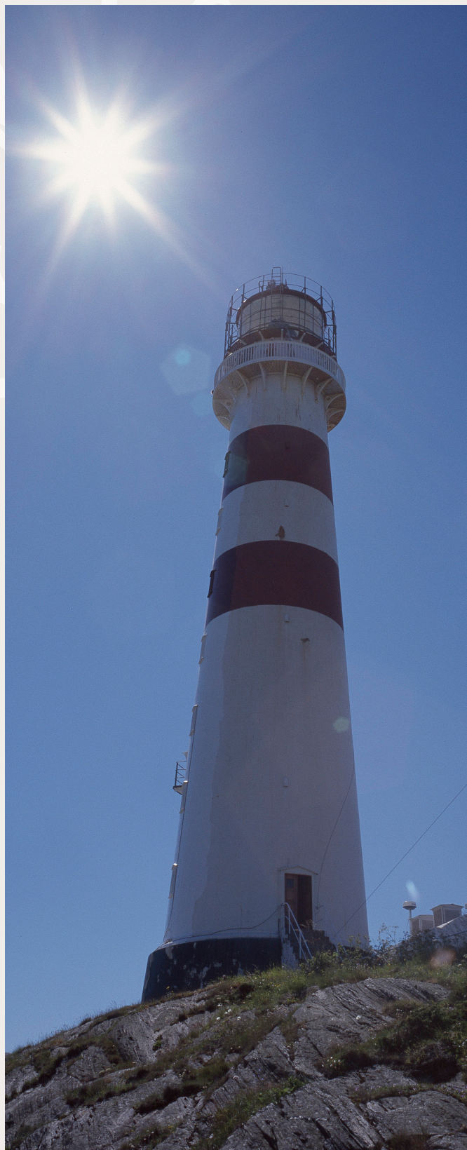
Oksøy fyrstasjon. Foto: Arve Kjerseim, Riksantikvaren
