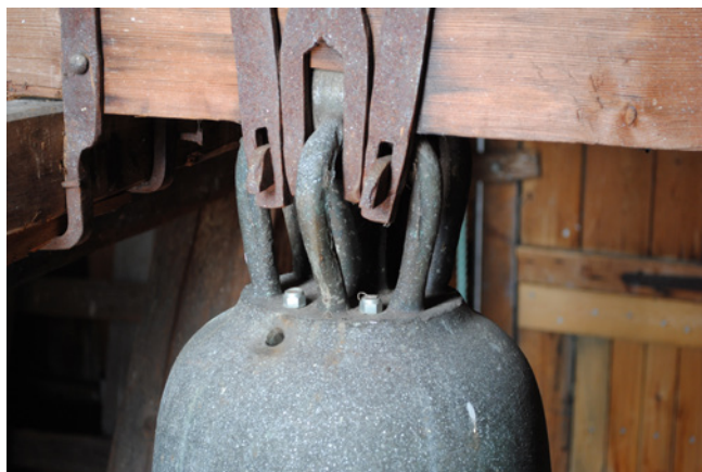
Ill. 16: Olberg kirke, Buskerud. Eksempel på klokke hvor det opprinnelige hengjernet til kolben har rustet bort, og hvor man har laget et nytt hengjernet som er skrudd fast gjennom kroneplaten. FOTO: TERJE DE GROOT.
