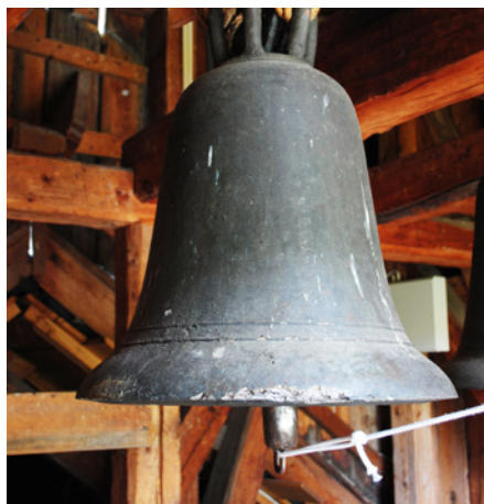
Ill. 32: Ved enkeltslag, kimning og klemting henger klokken stille, mens kolben slås mot slagringen. Illustrasjonsfoto fra Veggli kirke i Buskerud, hvor man slår enkeltslag ved hjelp av et tau festet i kolben. FOTO: TERJE DE GROOT.
