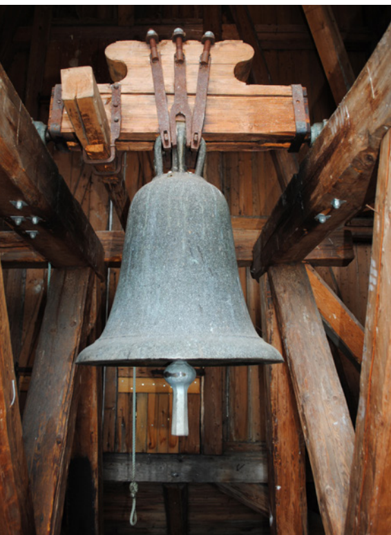
Ill. 4: Olberg kirke, Buskerud. Eksempel på klokke som er montert i rett aksel. Dette er den tradisjonelle og vanligste måten å henge opp kirkeklokker på.
