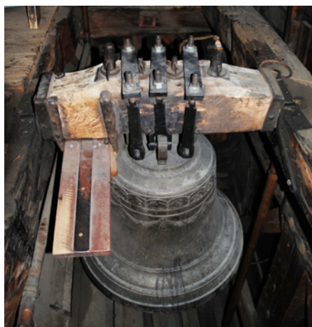
Ill. 31: Lom stavkirke, Oppland. En av svært få kirker hvor klokken ringes ved hjelp av «tramperings». FOTO: TERJE DE GROOT.
