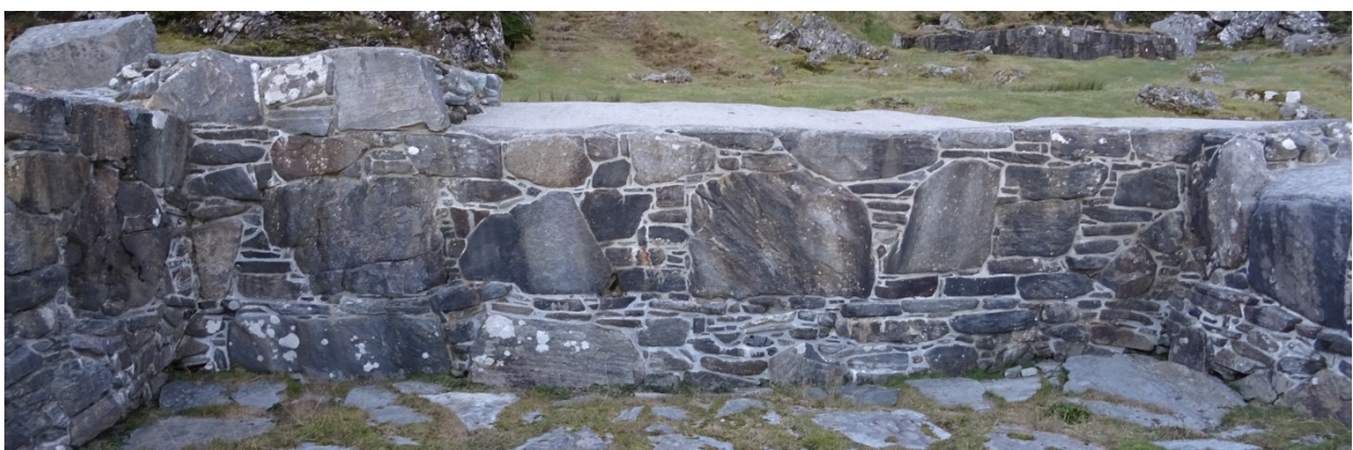
Bildet viser eksempel på ferdig spekket murverk, østvegg i matsal
