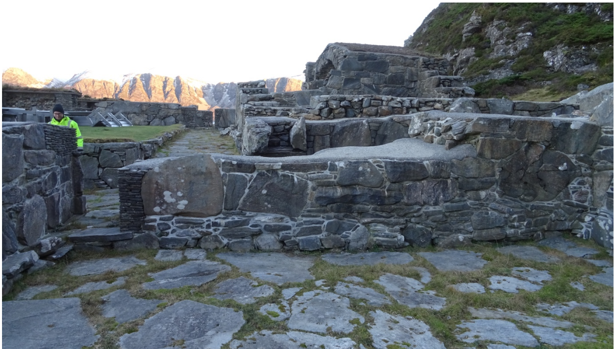
Bildet viser nordvegg i matsal ferdig spekket og med rensset toppdekke.
