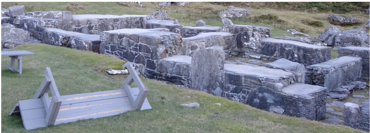
Bildet viser Kjøkken og matsal ferdig spekket og med rensa toppdekker i 2017
