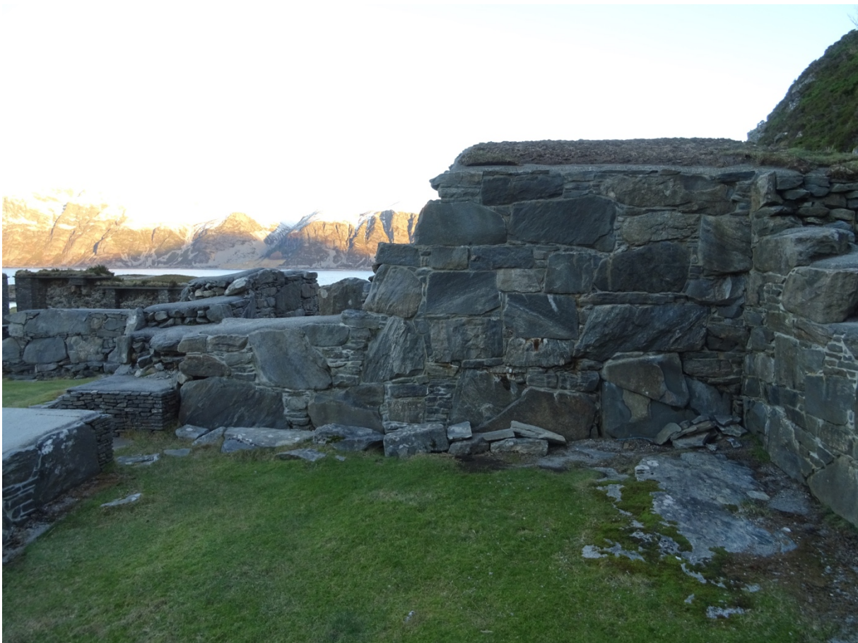
Foto B&M. Bildet viser nordvegg i kapitelsal ferdig spekket i 2017
