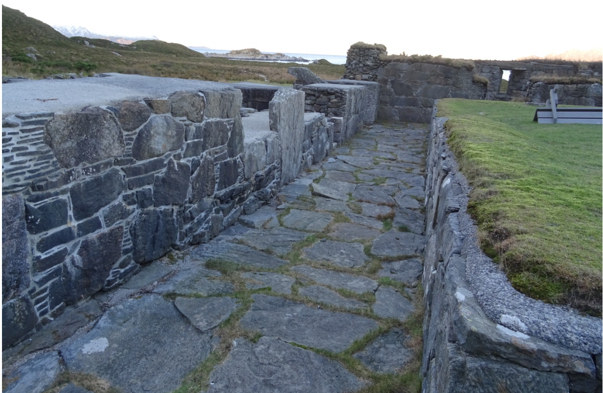
Bildet viser utvendige vegger i matsal og kjøkken sett fra klostergang. Murverk i vestfløy er med ferdig lagt bentonitt og ny torv.
