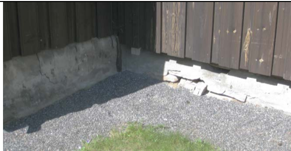
Hjørnet mellom nordvegg kor og østvegg sakristi ( til høyre i bildet)
