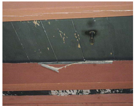
Fuktskader i malingen i himlingen i koret som sannsynligvis skyldes tidligere inntrengning av vann. 11
