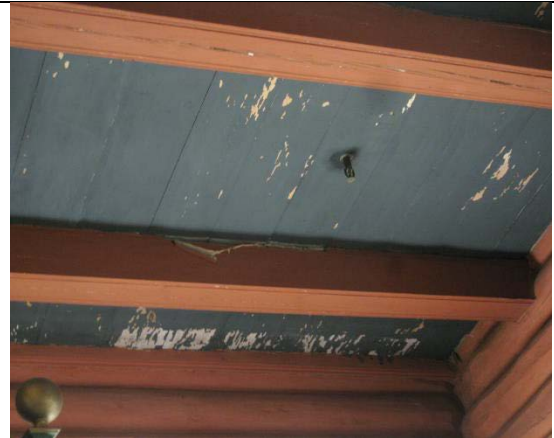
Fuktskader i malingen i himlingen i koret som sannsynligvis skyldes tidligere inntrengning av vann. 11
