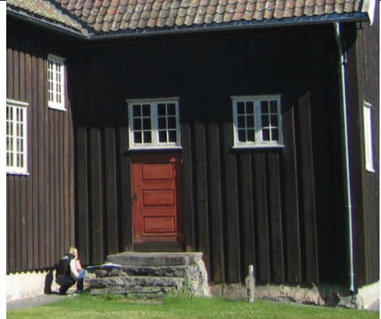
Oversiktsbilde med trappa på sydsiden av koret.
