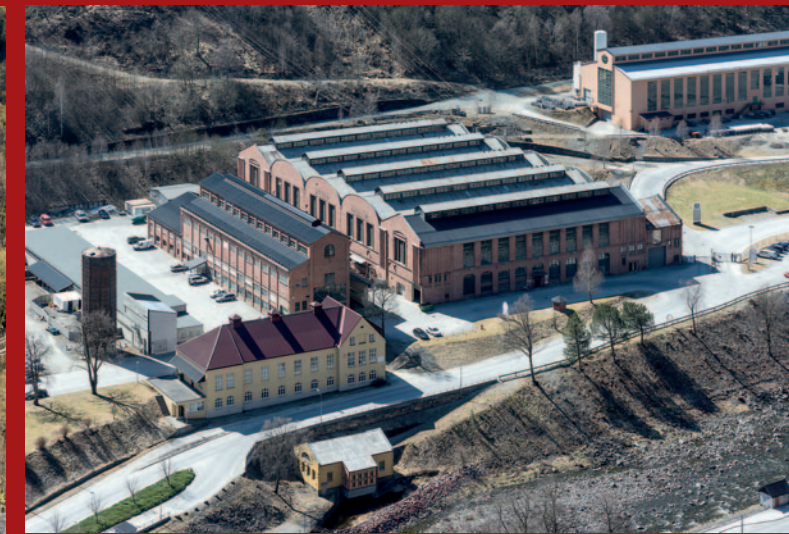
La zone industrielle de Rjukan, avec les bâtiments renfermant les fours à arc électrique et les dispositifs de refroidissement. PHOTO: Per Berntsen
