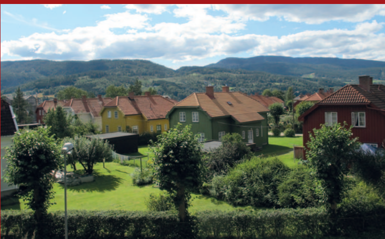
Logements ouvriers dans le quartier de Grønnbyen à Notodden. Photo: Trond Taugbøl, Directorate for Cultural Heritage
