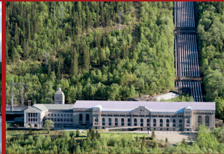
Vemork kraftstasjon, åsted for tungtvannsaktsjonen 27. februar 1943. FOTOGRAF: Per Berntsen
