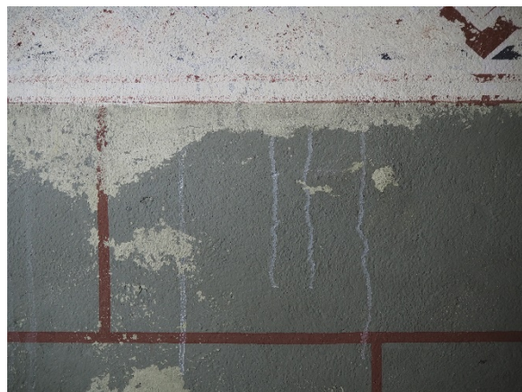
Figur 9: Detalj fra våpenhusets nordvegg. Hvite renner i dekoren.
