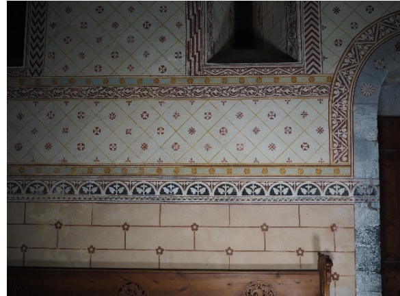
Figur 24: Skip. Sydvegg, veggavsnitt øst for portal.
