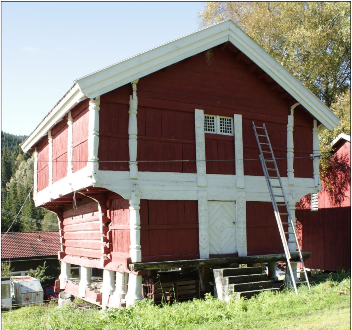
Figur 1. Skjønne, Søre. Loftet sett fra sydøst. Foto. J. Brønne. September 2017.
