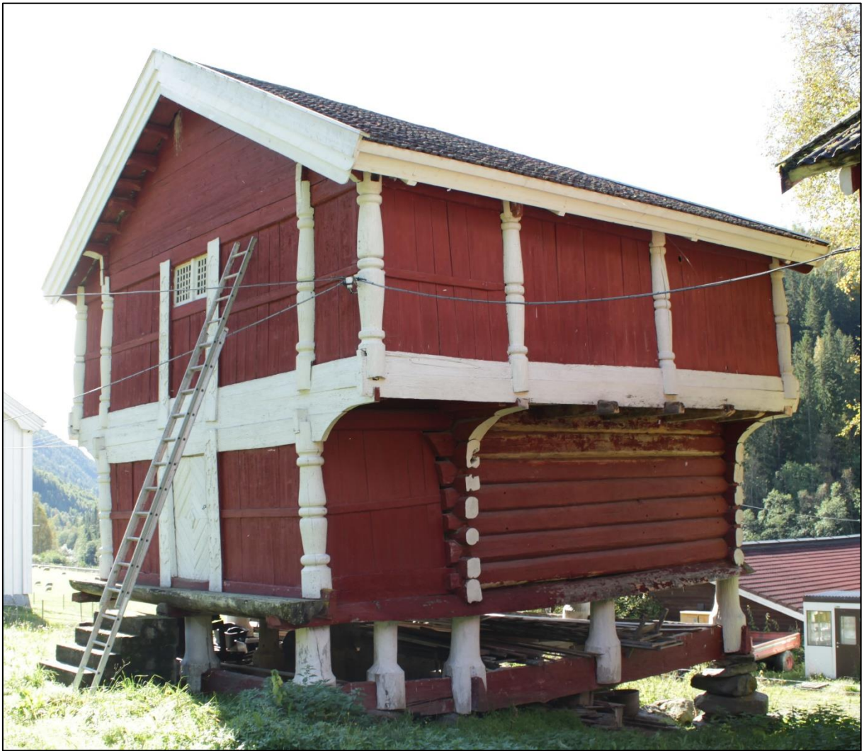
Figur 6. Skjønne, Sørre. Loftet sett fra nordøst. Foto. J. Brønne. September 2017.
