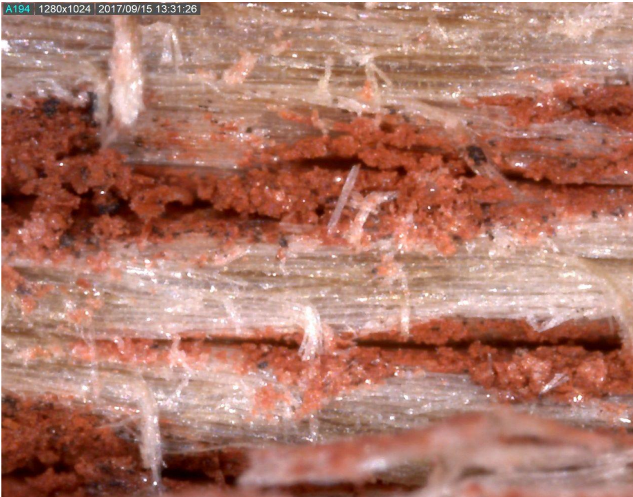
Figur 7. Skjønne, Søre. Rester av det porøse, eldste emulsjonsmalinglaget på sydveggen. Foto. J. Brønne. November 2017.
