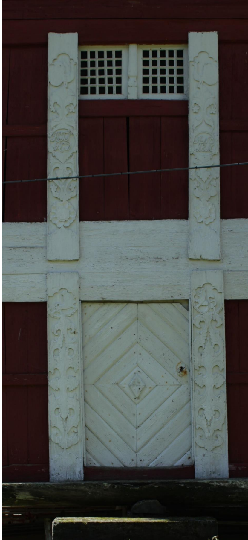
Figur 14. Skjønne, Søre. Detalj av østveggen med de utskårne dørgeriktene, svalgangsstolpene i 2. etasje, vinduet og døra. Vinduet har kun hvite malinglag, og kan være eldre enn resten av fasadeutstyret. Foto. J. Brønne. September 2017.
