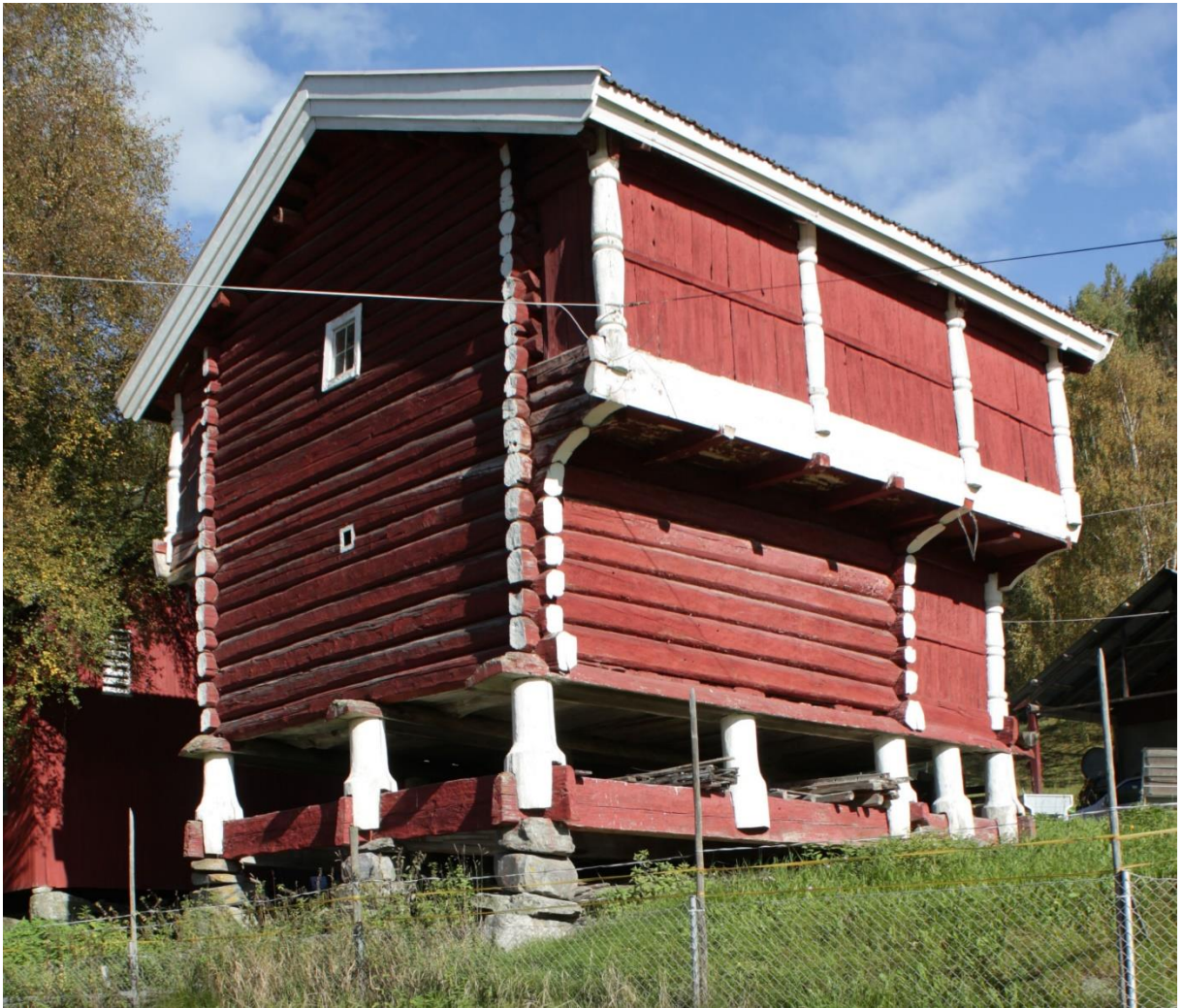
Figur 3. Skjønne, Søre. Loftet sett fra sydvest. Foto. J. Brønne. September 2017.
