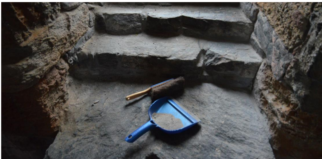
Figur 3: Oppsamling av nedfalt materiale fra vindussmyg i klokkeetasjen
