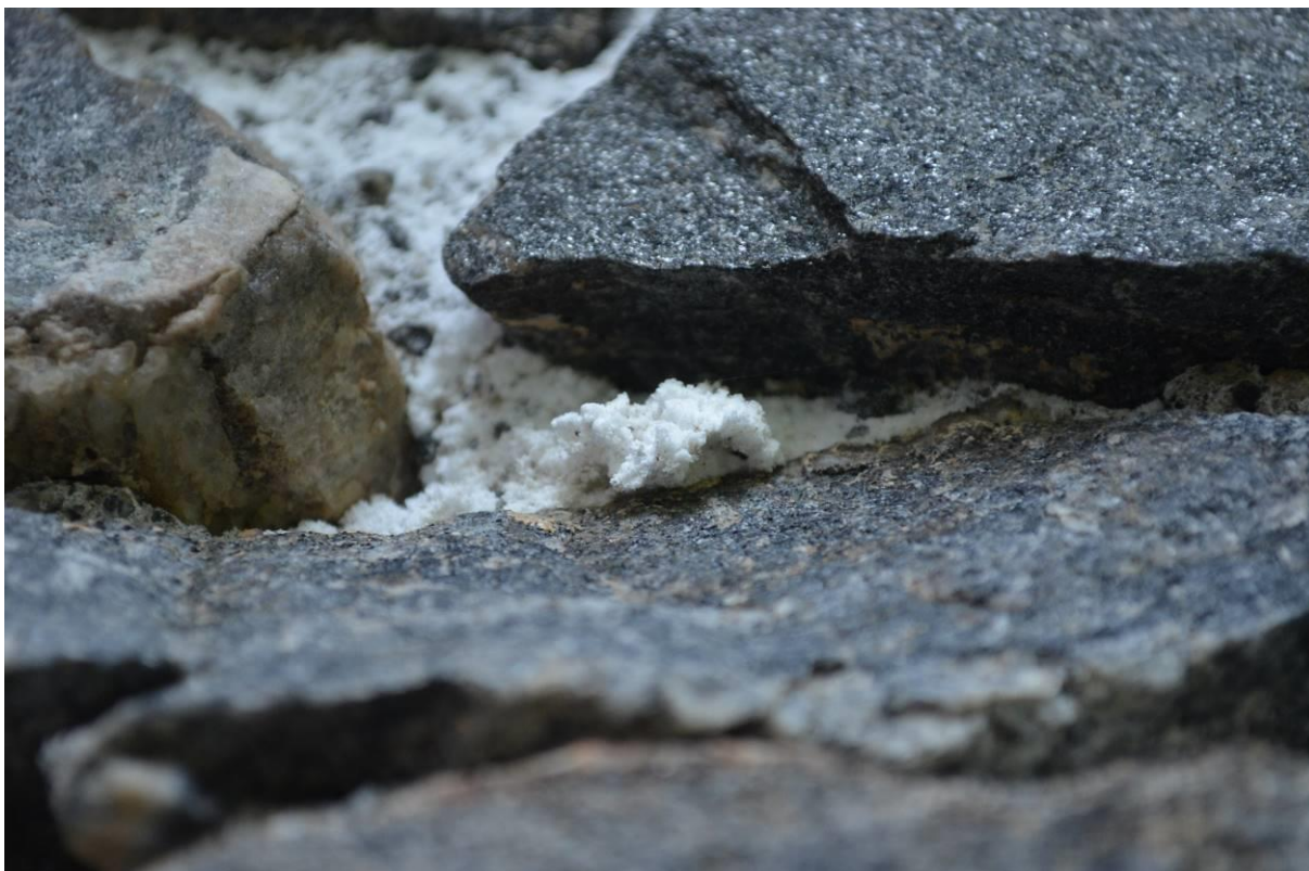
Figur 26: Murverk utendørs i skipet på kirken, nordveggen, nær tårnet (der man får et innblikk i den gamle murkjernen). Her dreier det seg om natriumkarbonat fra sementmørtel benyttet for tidligere reparasjoner. Det kan til tider være svært mye salt i dette området, mer når det er tørt enn når det er fuktig.
