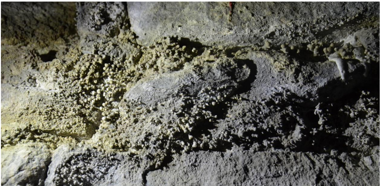
Figur 21: «Blomkålskorper» av kalk ( \text{CaCO}_3 ) er også vanlige. Disse er nok i mindre grad knyttet til tidligere restaurering med sement, men heller til oppløsning av gammel kalkmørtel i et meget fuktig miljø og påfølgende utfelling. Slike skorper kan sammenlignes med stalaktitter i kalksteinshuler.
