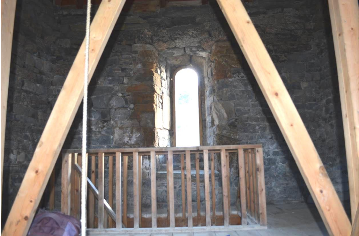
Figur 13: 24.10.2016: Etter en svært tørr periode er sørveggen i klokkeetasjen nesten helt tørr.
