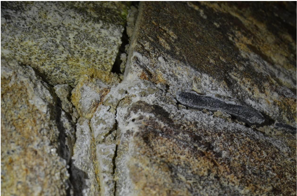
Figur 23: Saltutblomstringer i den nederste etasjen. Her dreier det seg sannsynligvis om natriumsulfater ( \text{Na}_2\text{SO}_4 \cdot \text{H}_2\text{O} )/( \text{Na}_2\text{SO}_4 \cdot 10\text{H}_2\text{O} ). Disse kommer fra restaurering med sement og videre reaksjon med «gammel» sulfat i murverket, trolig fra metaolivinstein. Steinen har et visst innhold av sulfid, som ved forvitring går over til sulfat.
