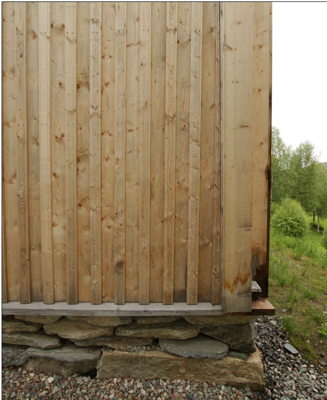
Figur 7. Ålen. Langlandbygningen. Detalj av panelet på sydveggen. Foto: J. Brønne. 17.6.2017.
