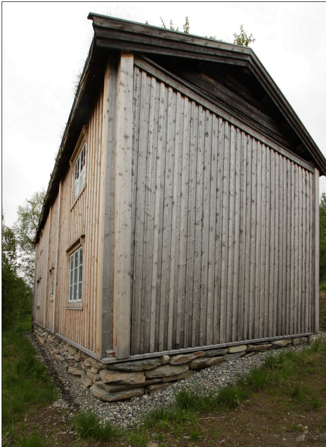
Figur 4. Ålen. Langlandbygningen. Sett fra nordøst. Foto: J. Brønne. 17.6.2017.
