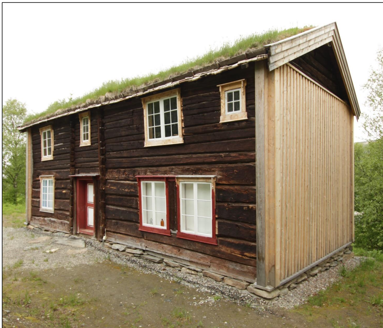
Figur 2. Ålen. Langlandbygningen. Sett fra sydvest. Foto: J. Brønne. 17.6.2017.
