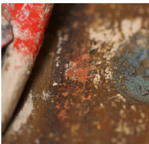
Ill. 18. Rødt lag, trolig original mønje under overmaling på korset. Foto: NIKU 2011.
