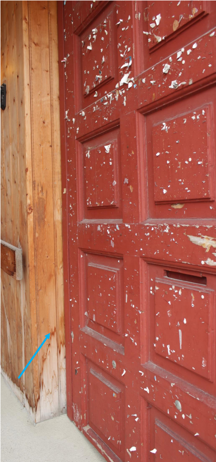
Figur 5. Røros. Bergmannsgata 19. Portrommet. Veggfeltet markert med blå pil skal males med veggfargen fram til den grønne veggfargen bak porten. Foto: J. Brønne 14.6.2017.
