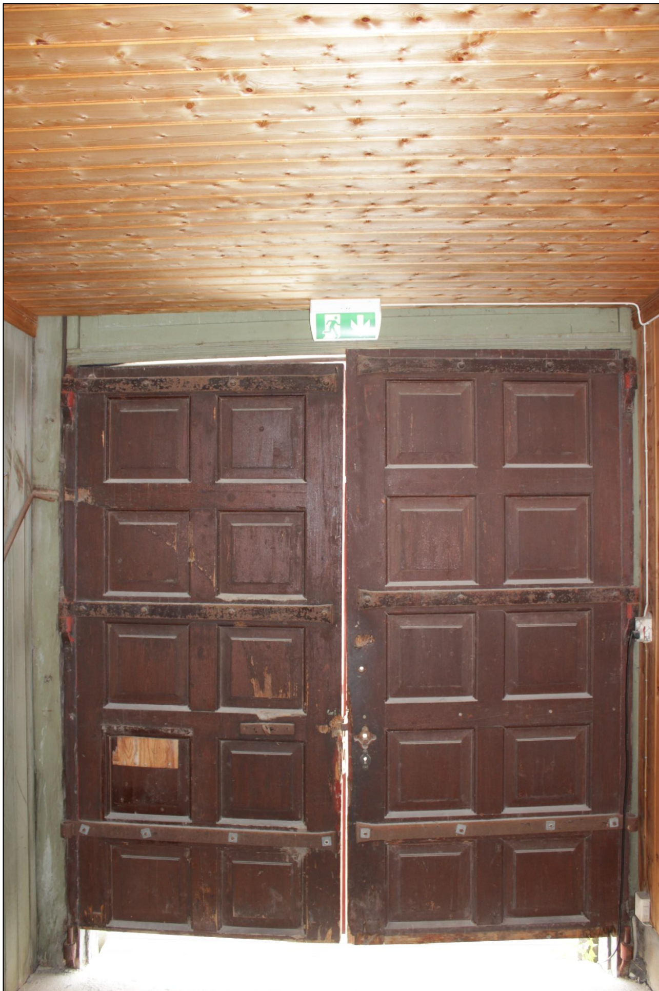
Figur 8. Røros. Bergmannsgata 19. Portrommet. Innsiden av portene og resten av veggfeltene på vestveggen skal ikke overmales. Foto: J. Brønne 14.6.2017.
