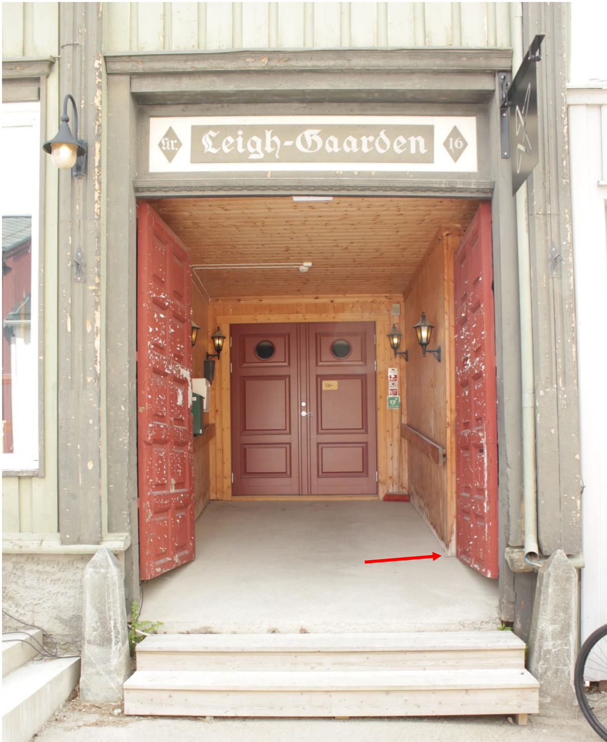
Figur 1. Røros. Bergmannsgata 19. Portrommet sett fra Bergmannsgata. Fra gata går en simpel tretrapp, og en skrå betongrampe som ble etablert da ble etablert en dagligvarehandel i Engzeliussgården. Rampen fortsatte ut i gata. Se figur 2. Hvis rampen fjernes til det punktet som er markert med en rød pil, vil det kunne etableres en trapp fra det punktet og innover mot døra til Kulturminnefondet. Det vil også være mulig å rekonstruere de forhuggete delene nederst på begge portbladene slik at porten kan lukkes og låses. Foto: J. Brønne 14.6.2017.
