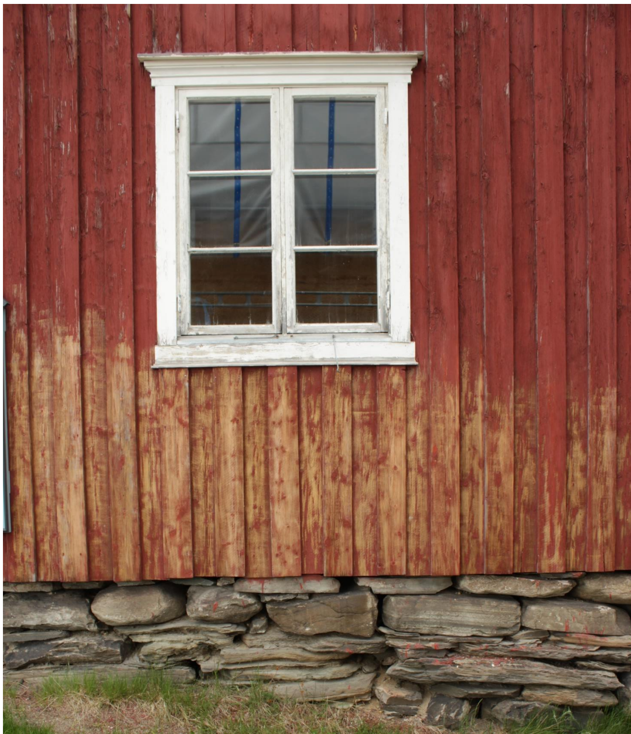
Figur 5. Røros. Vognbua. Vinduet i sydfasaden. Foto: J. Brønne. 12.6.2017.
