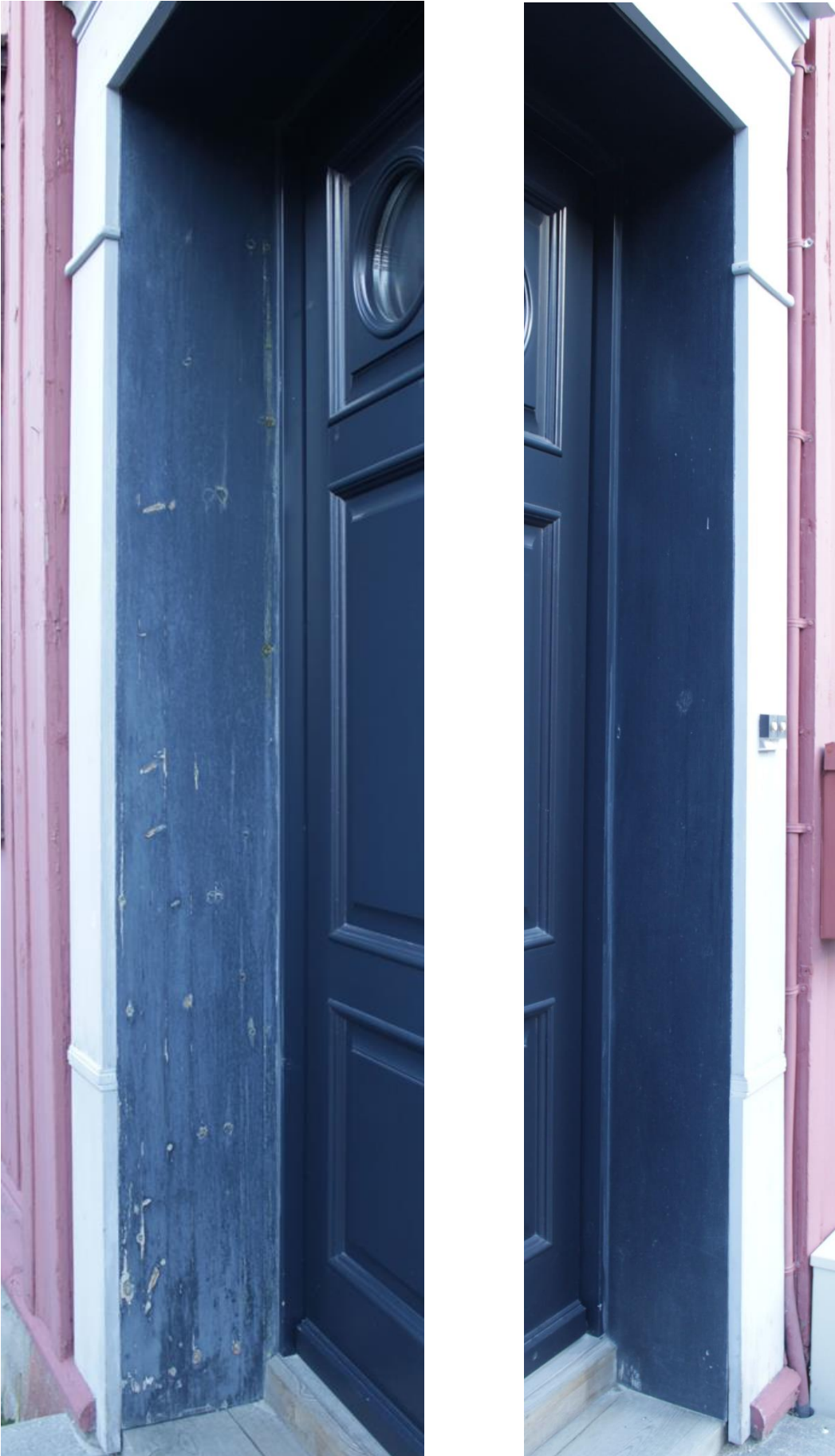
Figur 10. Røros. Flanderborg 5. Detalj av malingsskadene på dørkarmene. Til venstre er den nordre dørkarmen som får direkte sollys om ettermiddagene om sommeren. Karmen har nedbrytningsskader i det området som er mest utsatt for sollys. Til høyre den søndre dørkarmen. Karmen får ikke direkte sollys, og er nesten uten skader. Foto: J. Brønne. 8.7.2016.
