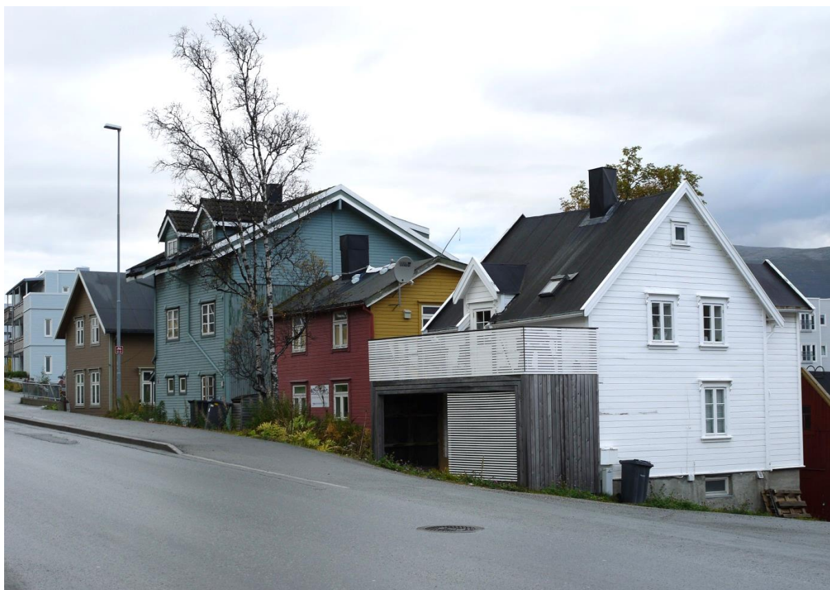
Bolighusene og naustene i Strandvegen 80-86 er blant de 289 objektene regulert til bevaring som inngår i undersøkelsen av verneverdige kulturminner i Tromsø kommune. De verneverdige kulturminnene hadde bedre tilstand (2 % truet) enn SEFRAK-bygninger uten vern (12 % truet/sterkt truet). Foto (190630560-190630625): ÅD/NIKU 2016
