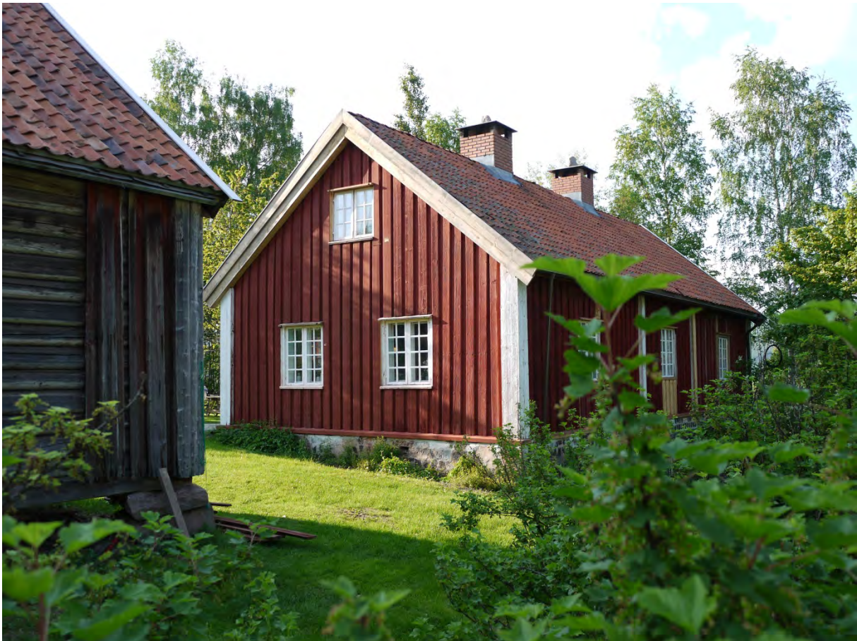
Uthusbygningen og våningshuset på Øvre Burås er prioritert i Nittedal kommunes kulturminneplan som kulturminner av svært høy verdi. Foto (02330017031-032): ÅD/NIKU 2016
