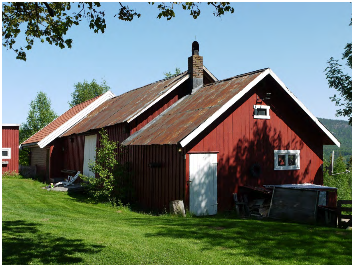
Driftsbygninger og mindre uthus har noe høyere akkumulert tap og mer forfall på gjenstående bygninger enn gjennomsnittet i Nittedal. Tapsandelen i 4. omdrev er imidlertid lavere enn gjennomsnittet for alle undersøkte SEFRAK-bygninger i kommunen. Foto (02330009018): ÅD/NIKU 2016
