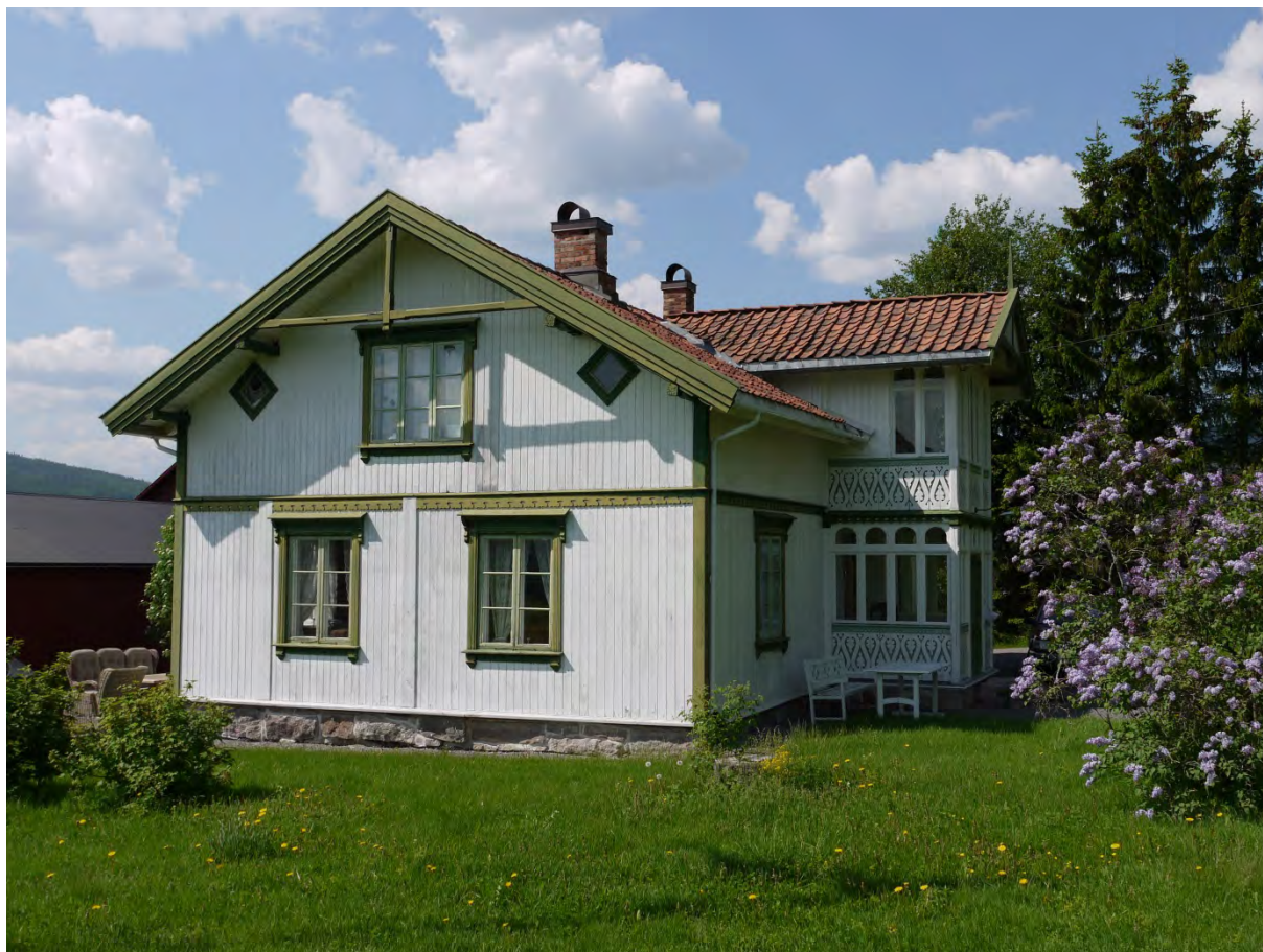
Hovedbygningen på Nordre Haug er én av 249 undersøkte SEFRAK-bygninger eldre enn 1900 i Nittedal. Bygningen er registrert som middels endret (B-endring) og tilbakeført til eldre uttrykk. Foto (02330018029): ÅD/NIKU 2016
