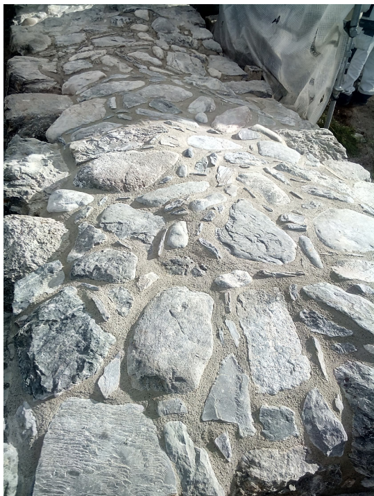
To nymurte toppdekker med fall ut mot hver side av murverket
