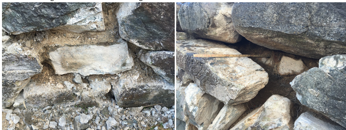
Foto av murverk i rom 114 under arbeid. På bildet til venstre er sementbaserte fuger hugget ut og oppløst fugemateriale sitter igjen. På bildet til høyre sees murverket når oppløst fugemateriale er fjernet. Utgangspunktet for det videre konserveringsarbeidet er fuger som er opp til 60 cm. dype
