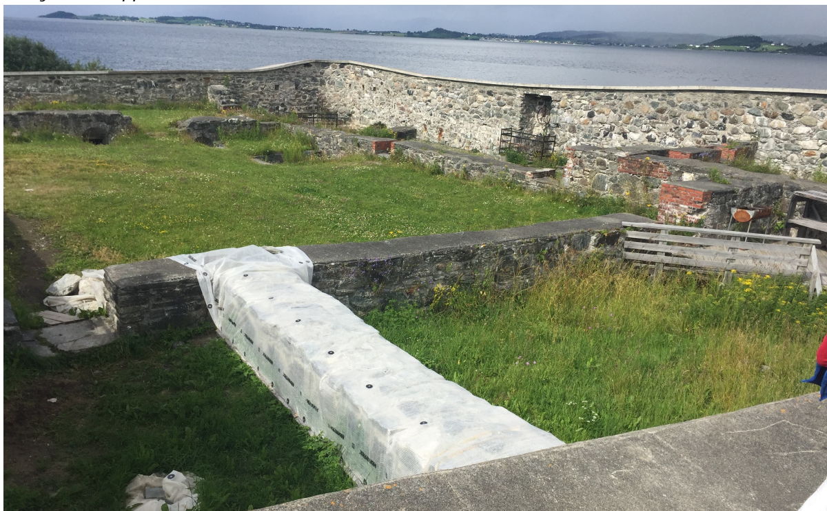
Etter at murverket er konservert står det åpent med tak over og ettervannes de første 6 uker. Senere blir murverket pakket ned de neste tre høstmånedene.
