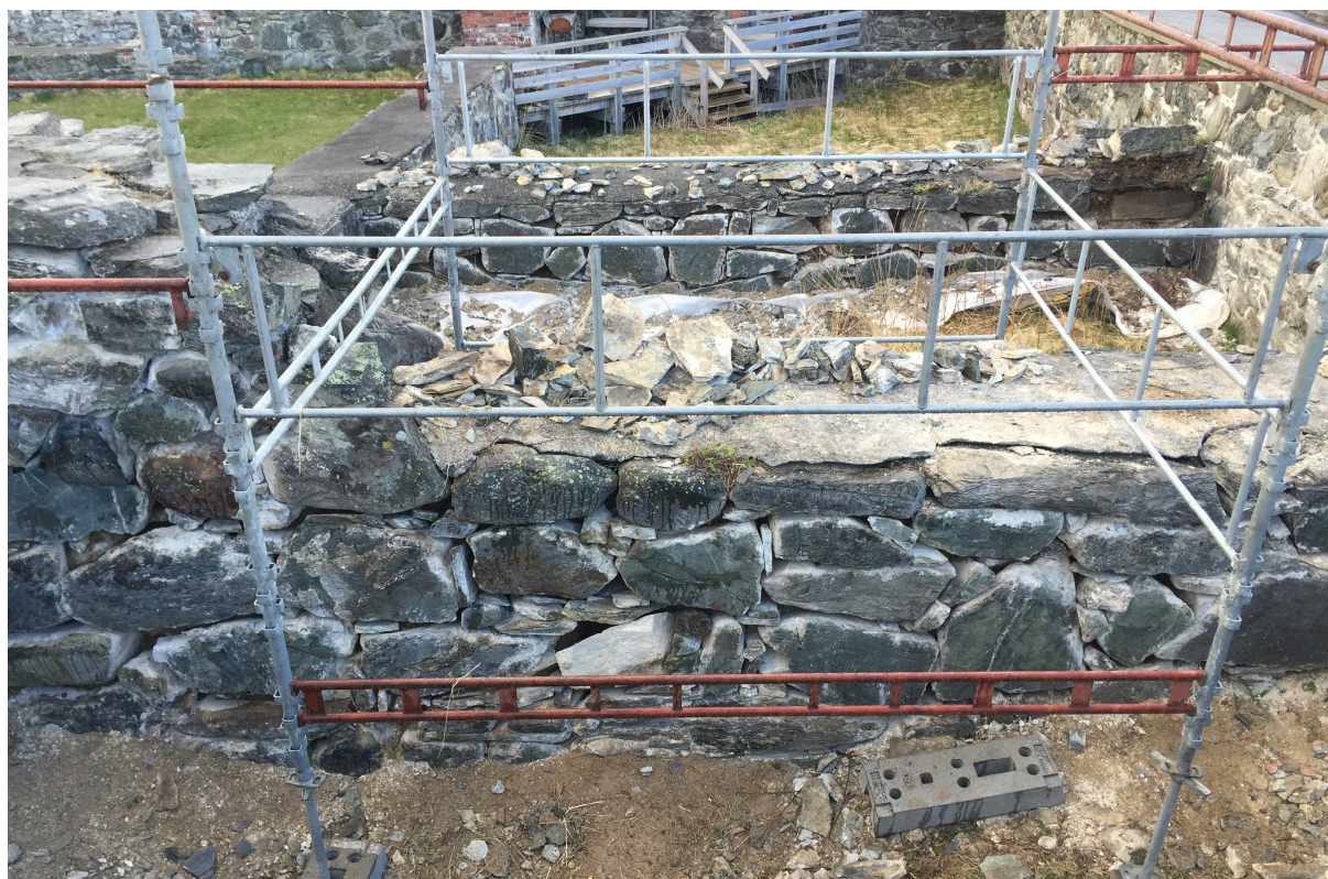
Foto av rom og murer mellom 114, 115 og 116 under arbeid
