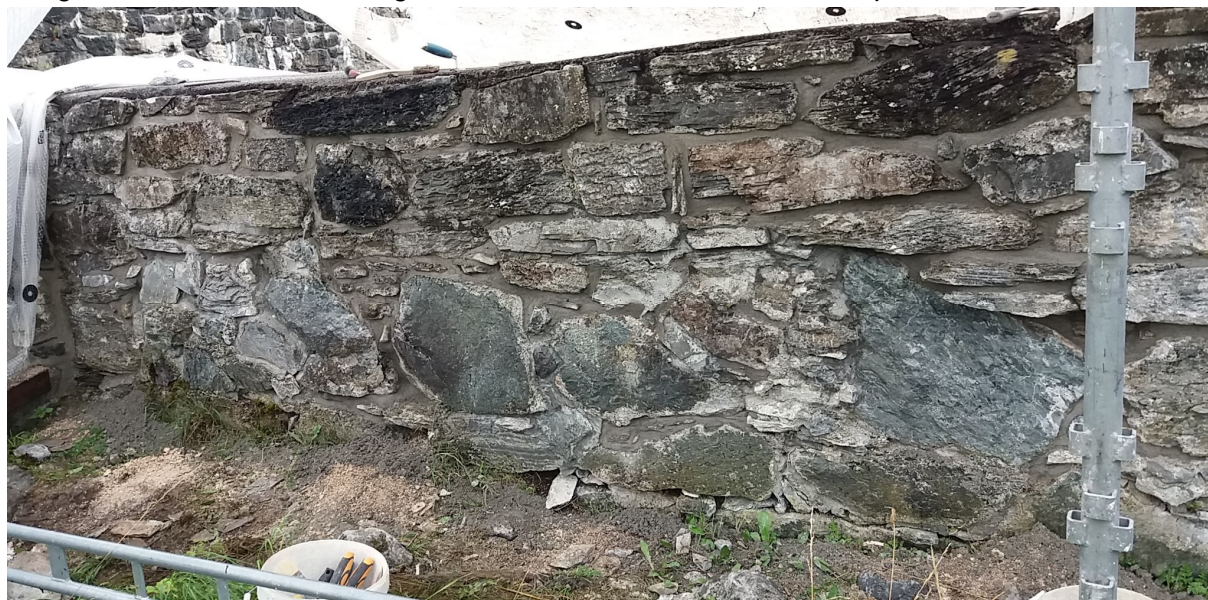
Foto av mur mellom borggård (120) og rom 114 og 115 under reparasjonsarbeid
