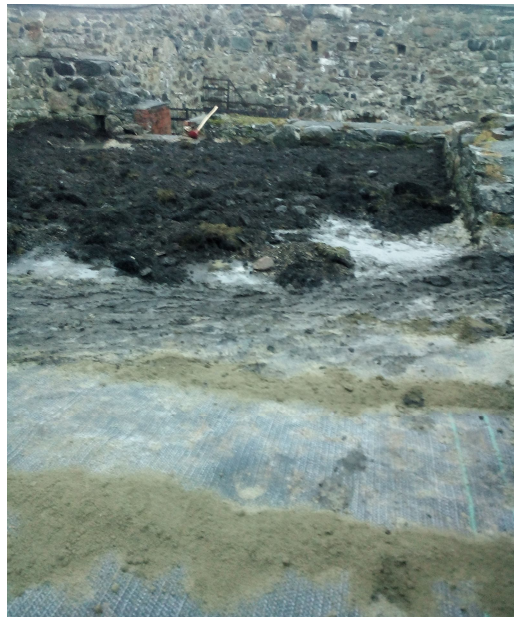
Bildet til venstre viser ferdig lagt bentonitt duk og alle skjøter er sikret med ren bentonitt. Bentonitt-duken er ren bentonitt sydd inn i mellom to filtduker. Bildet til høyre, tilbakeføring av jord.
