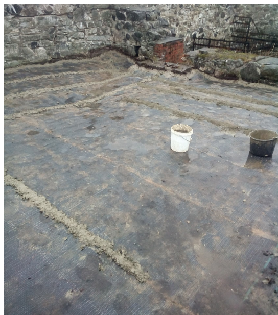
Bildet til venstre viser ferdig lagt bentonitt duk og alle skjøter er sikret med ren bentonitt. Bentonitt-duken er ren bentonitt sydd inn i mellom to filtduker. Bildet til høyre, tilbakeføring av jord.
