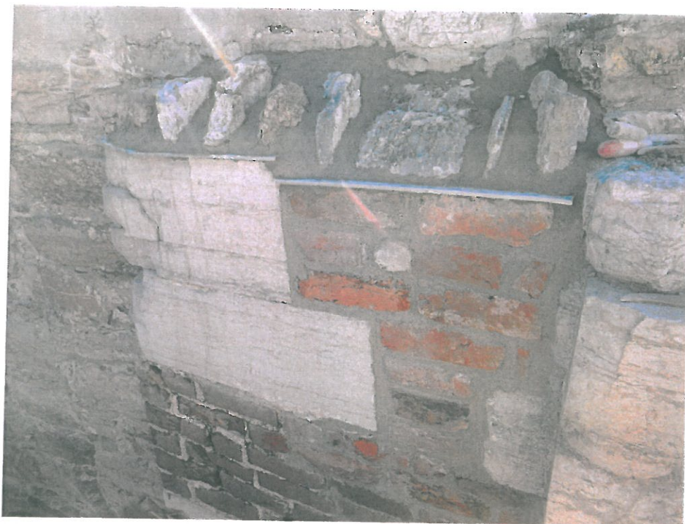
Vangen i østre trappeløp ferdig med sinkplate og toppdekke
