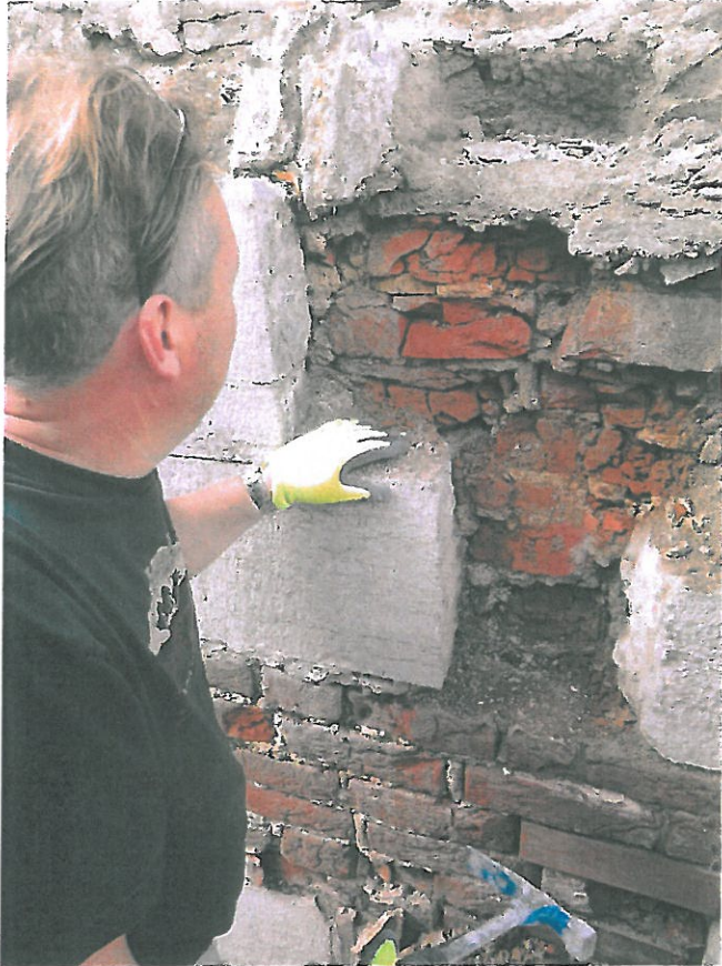
Fjerning av sterkt forvitret tegl. Vestre vange, østre trappeløp
