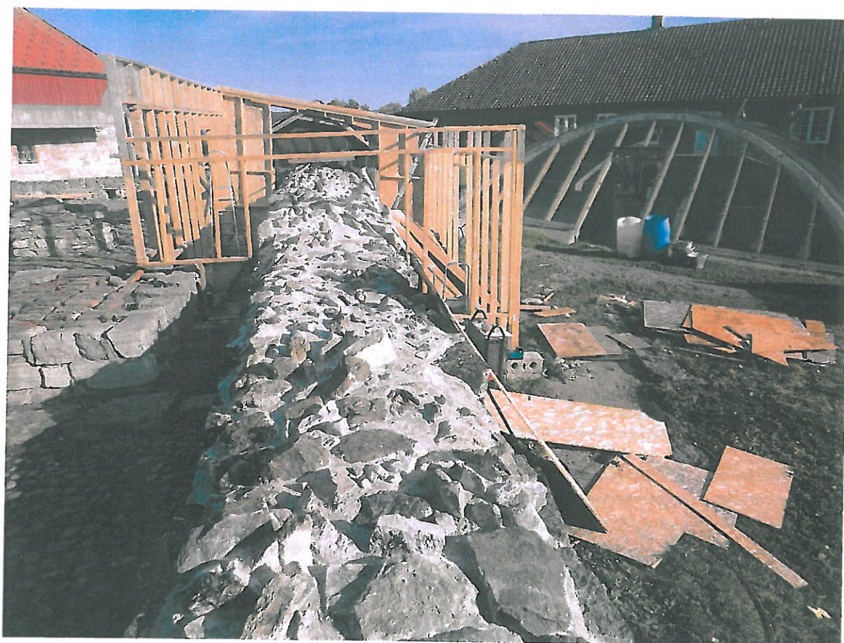
Riving av Vintervernebygg, Østre ringmur ferdig konservert
