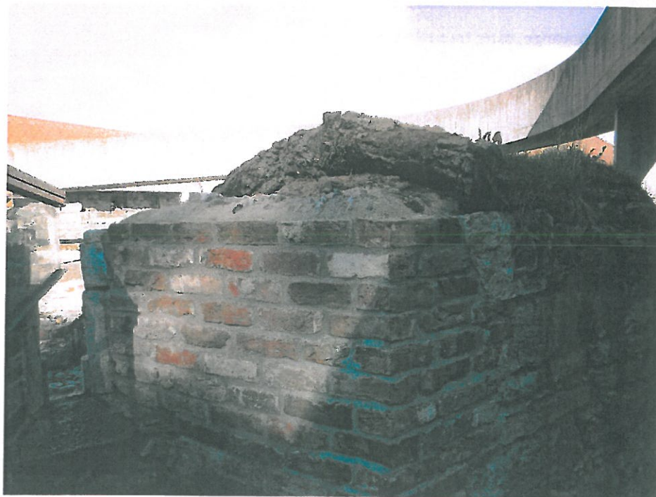
Østre vange ferdig oppmurt med nytt toppdekke.
