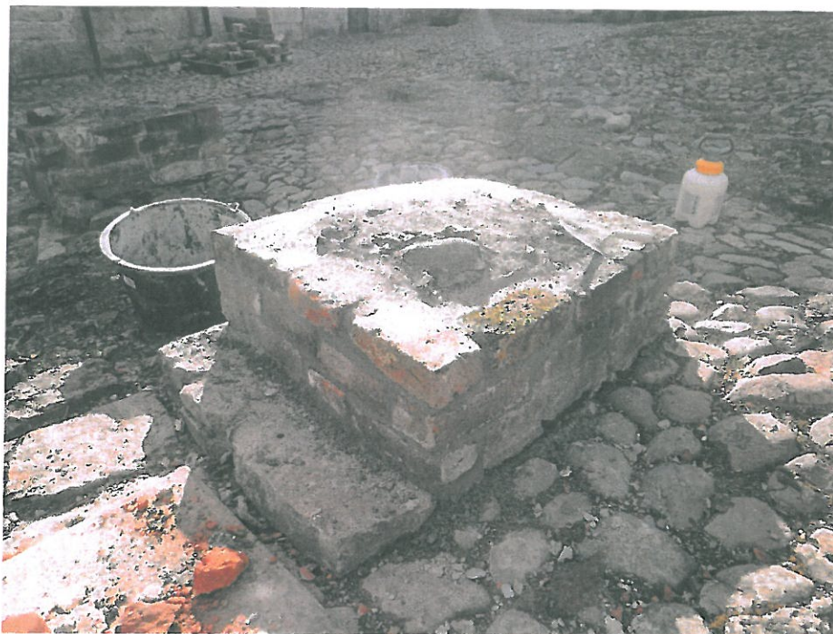
Søndre pilar i stekehuset ferdig konserverert
