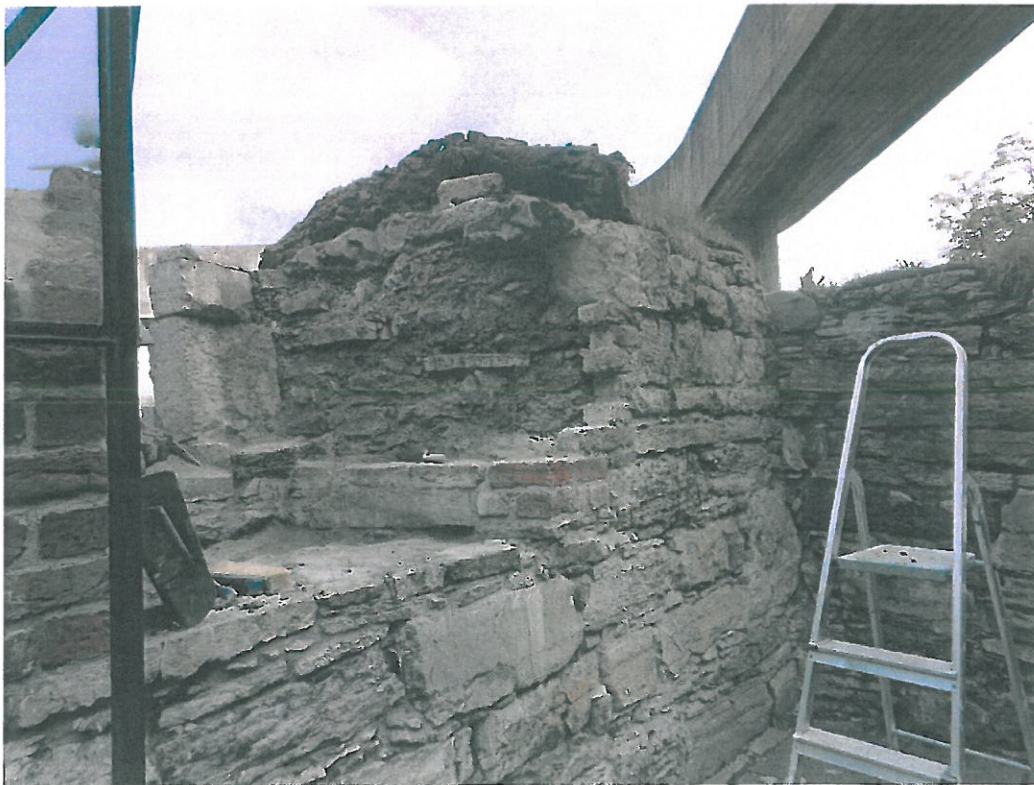
Teglsteinen i østre vindusnisje fjernet og toppdekket tatt av
