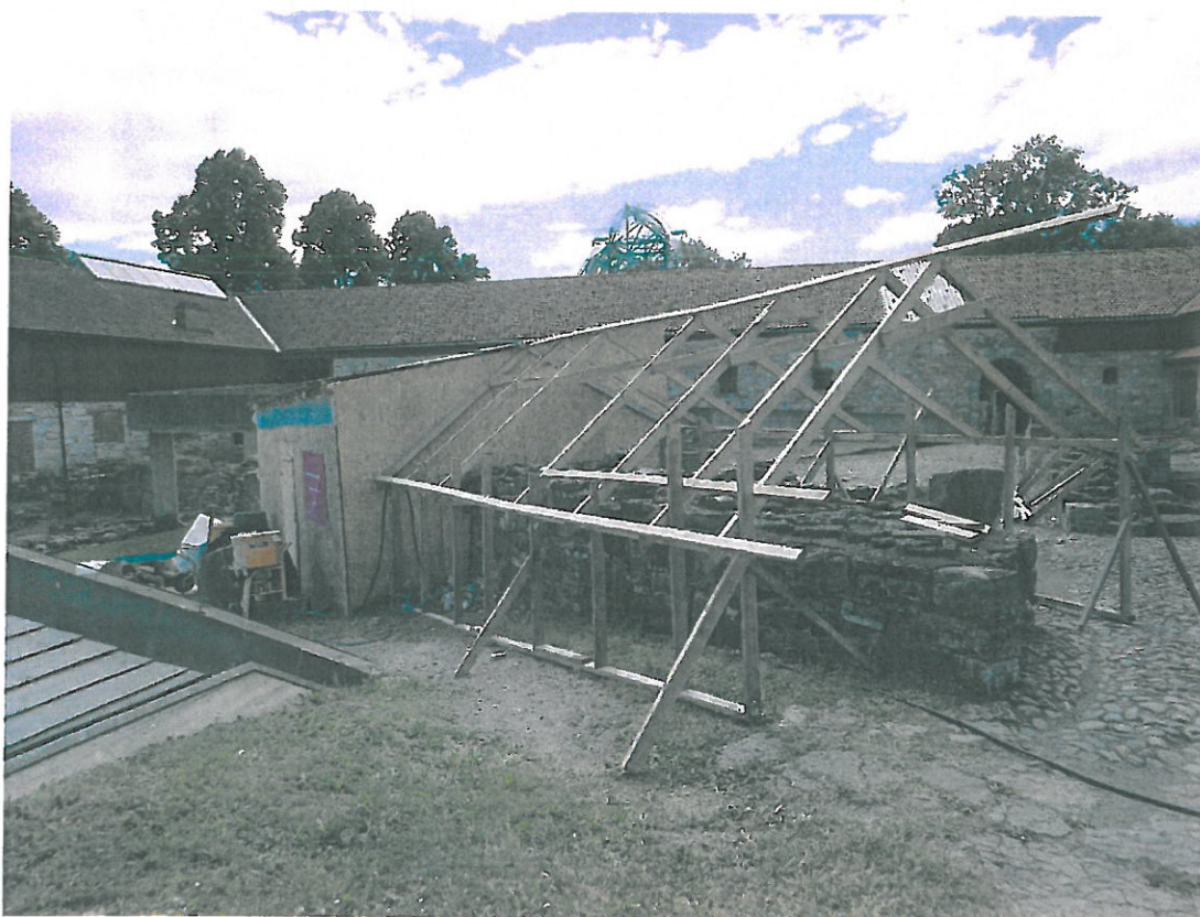
Oppføring av beskyttelsesbygg over siste del av østre ringmur
