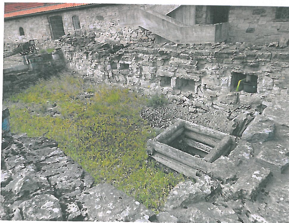
Torvlaget i bunnen av tårnruinen før fjerning
