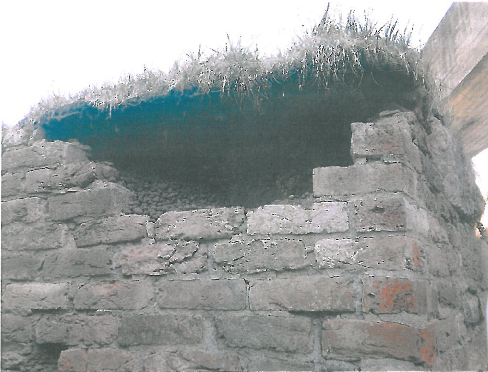
Nedring av skadet stein i østre vindusnisje
