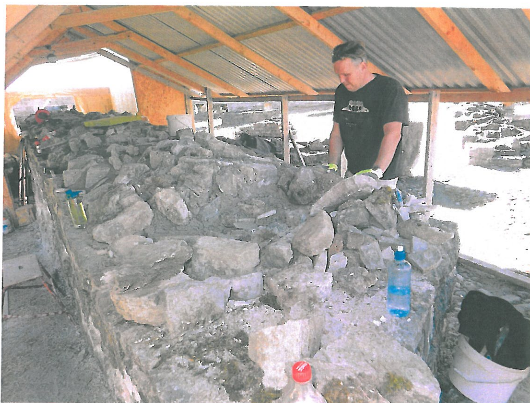
Muring av toppdekke over siste del av østre ringmur
