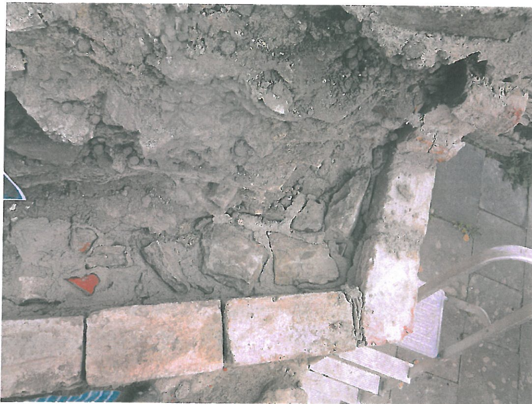
Oppmuring av ny vange i østre vindusnisje. Nytt fyll inn mot opprinnelig kalkkjerne
