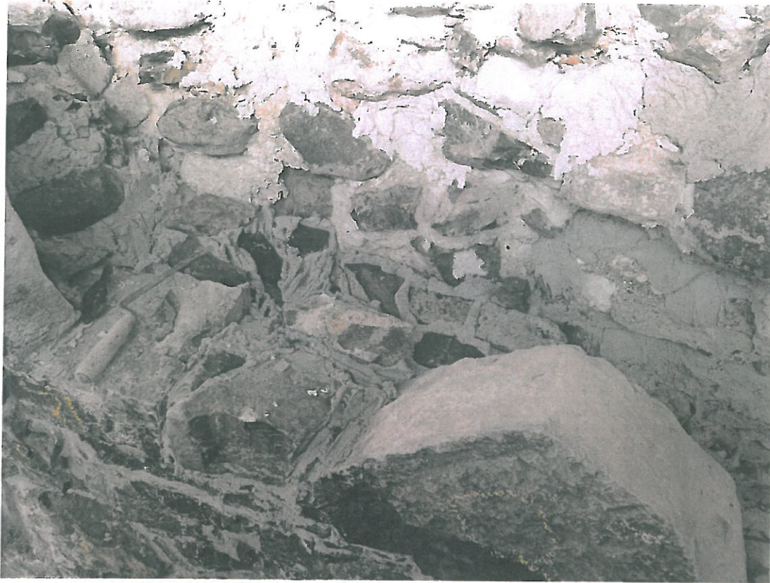
Oppbygging av vestre murvange og fylling inn mot kjernen
