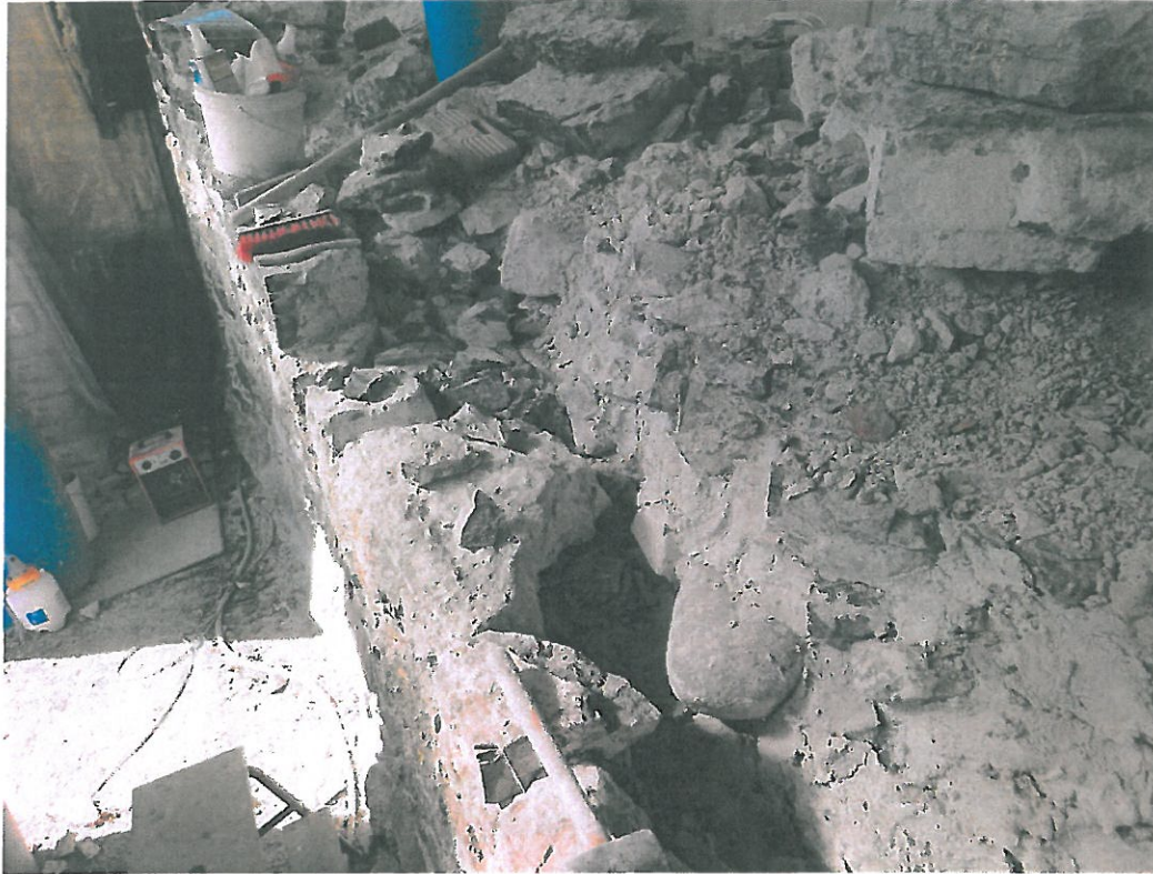
Oppfylling mellom murvange og opprinnelig murkjerne
