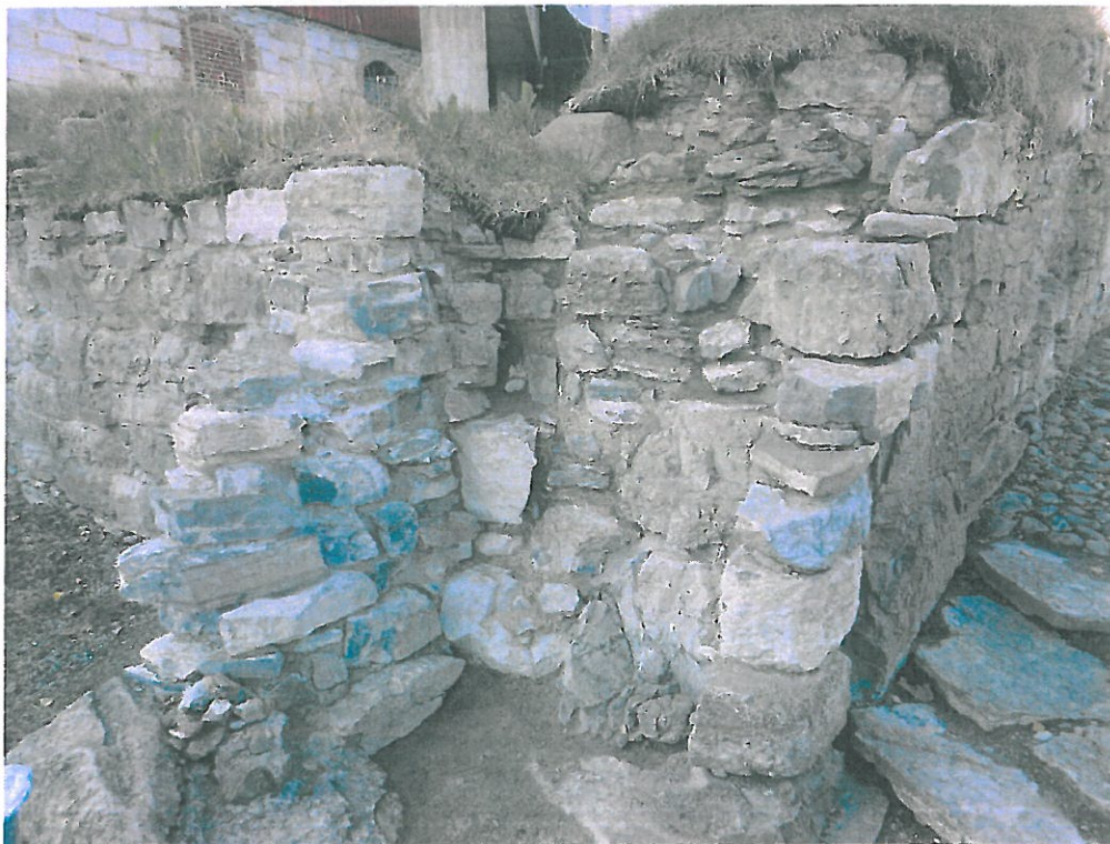
Enden av sydfløyens nordvegg med ny kalkmørtel på plass
