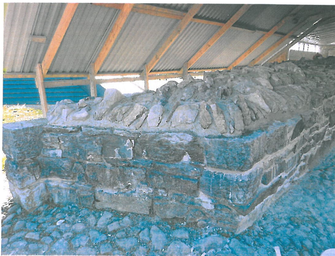
Siste del av østre ringmur ferdig med toppdekke
