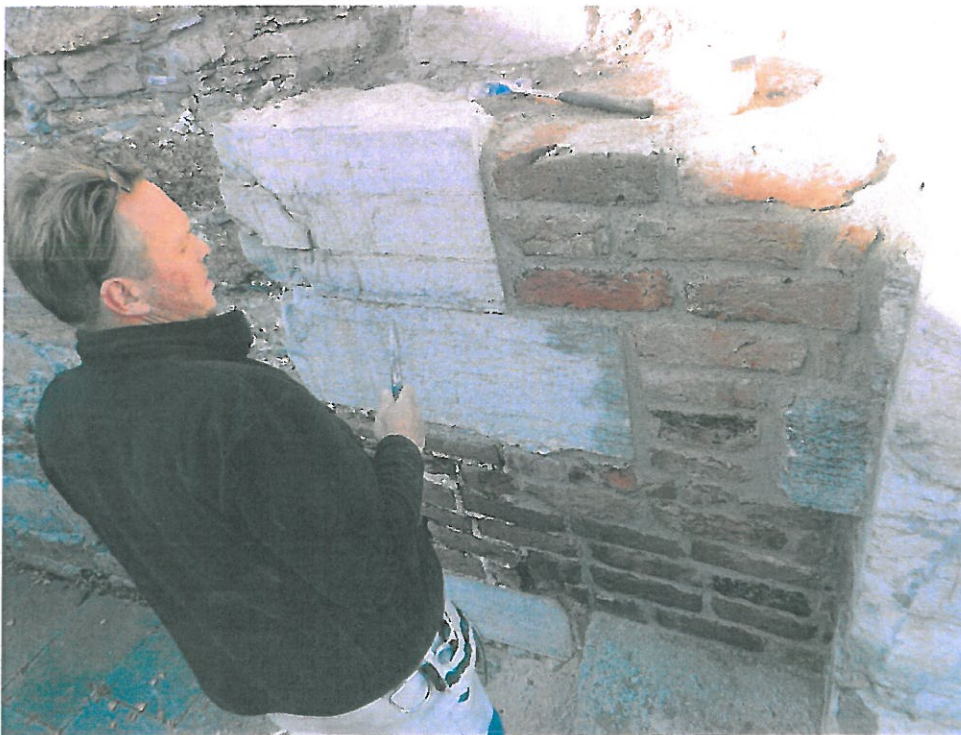
Vangen i østre trappeløp under gjenoppmuring
