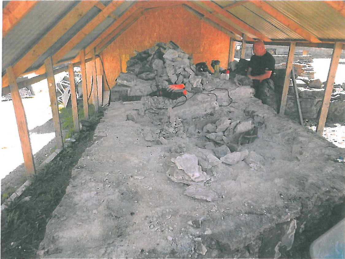
Fjerning av toppdekke i betong over siste del av østre ringmur
