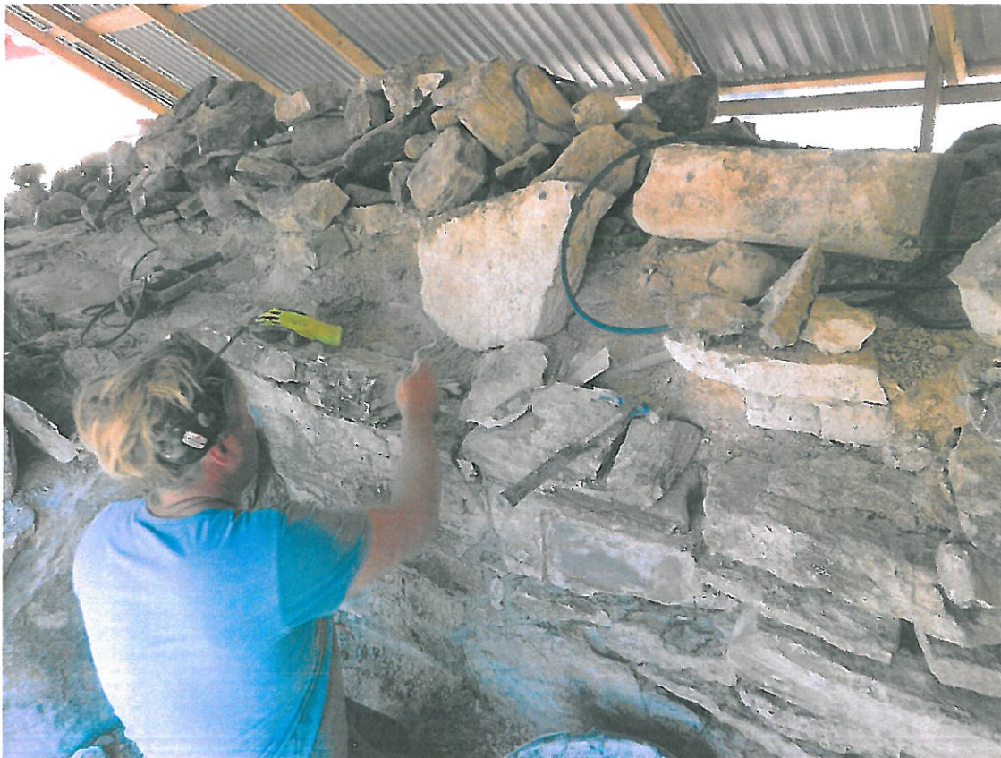
Oppmuring av vestre vange, østre ringmur
