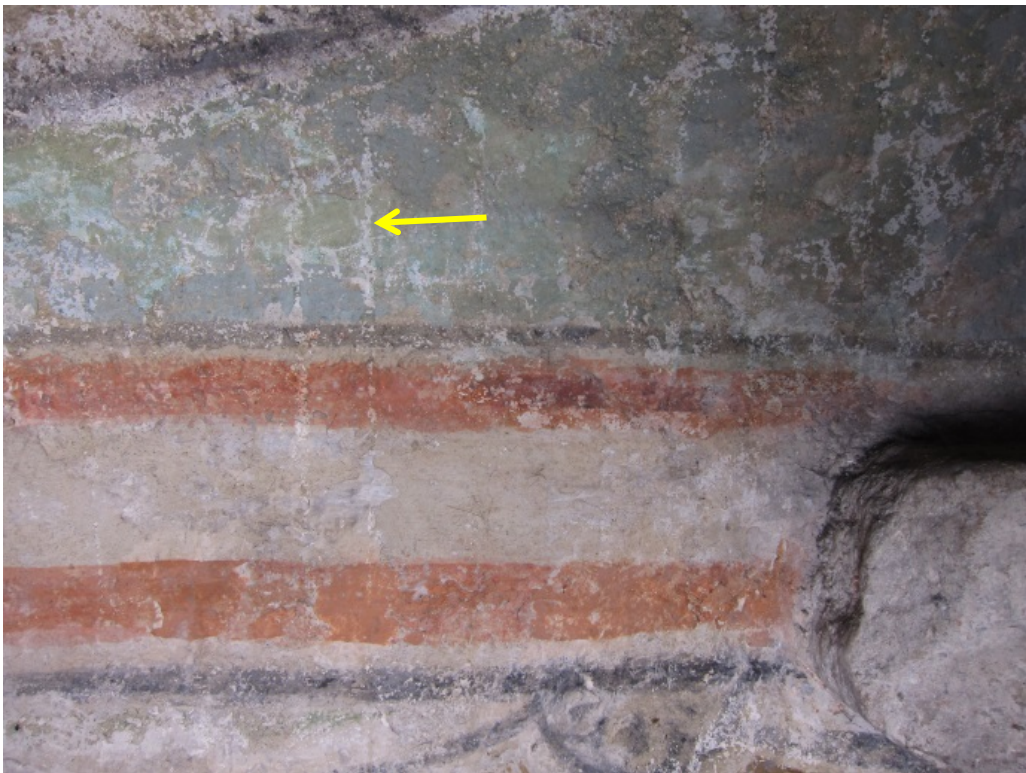
Figur 27: Kor. Vestvegg. Sør fra korbuen. I rennemerker er malingslaget gått tapt (pil).
