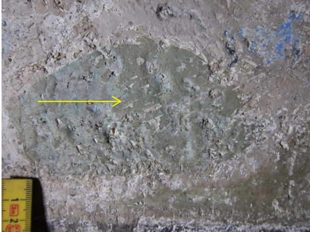
Figur 8: Kor. Sydvegg. Hakkespor (pil) fra avdekning på 1930-tallet.
