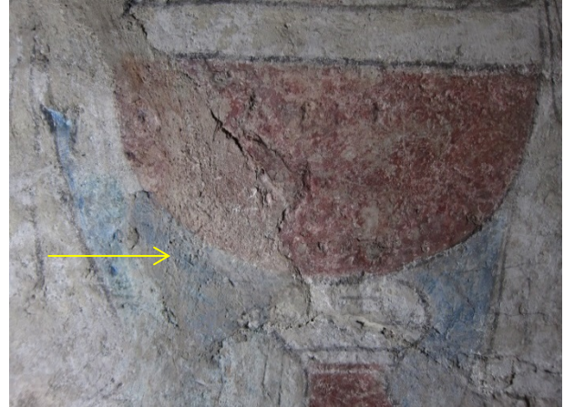
Figur 9: Kor. Himlingshvelvet mot syd. Tidligere pussreparasjon med retusj i form av lasurer.
