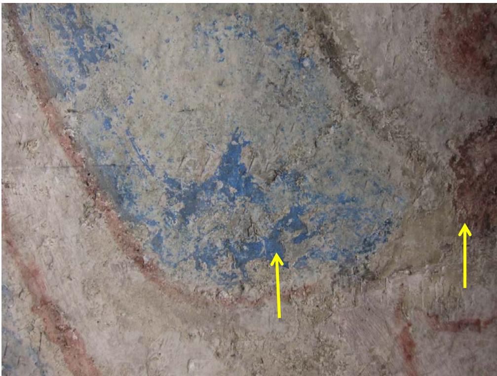
Figur 6: Kor. Hvelvet mot øst. Den originale malingen er påført i tykke lag (pil).
