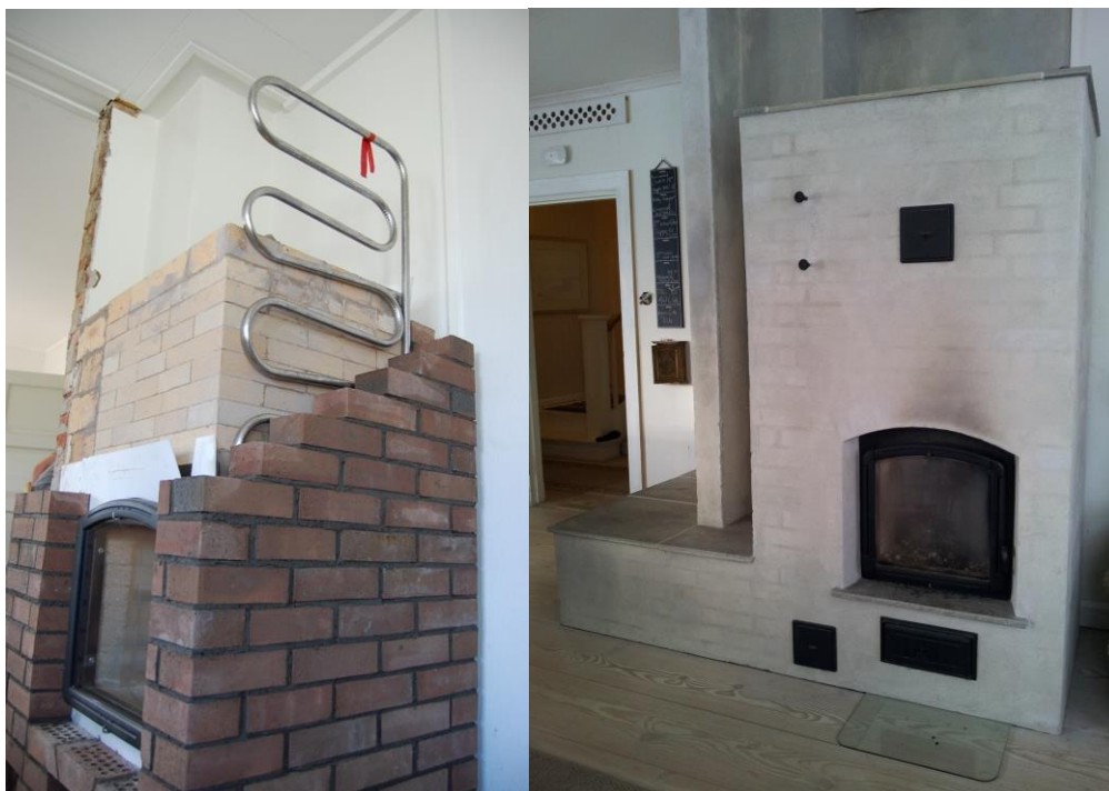
Figur 2 Masseovn i Villa Dammen under bygging og ferdigstilt. Foto: Bjørge Sandberg Kristoffersen
