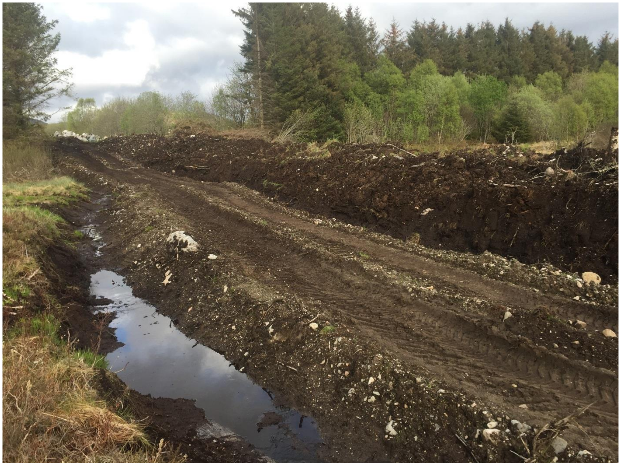
Figur 5-6 Bosetning-aktivitetsområde ved Kjørsvik, skadet av arbeider med landbruksvei. ID:123429.
