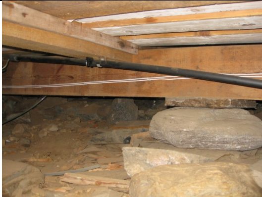
Bilde tatt i krypgrunn. Det er tørt under kirka.
