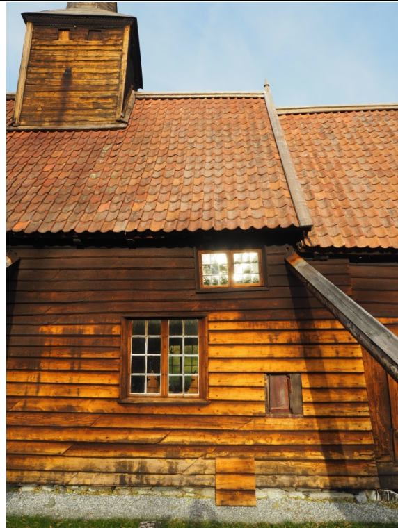
Inspeksjonsluke på utsiden av skipets sydøstre hjørne hvor stavkonstruksjonen kan sees.
