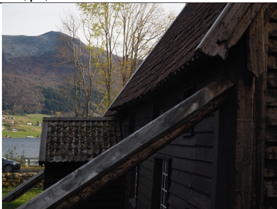
Skordene slipper, takket å være sine to langsgående dekkbord, fuktbelastning fra takfallene.
