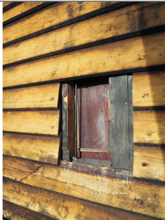
Detaljbilde av inspeksjonsluken. Her sees også et kamjern som fungerer som vertikal dragere.
