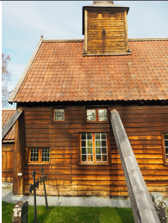
Sydfasade av skipet med våpenhus til venstre i bildet. Mellom de to vinduene mot vest er den gamle inngangen, nå dekket med panelkledning.
