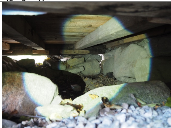
Detalj bilde. Grunnmur under våpenhus.
