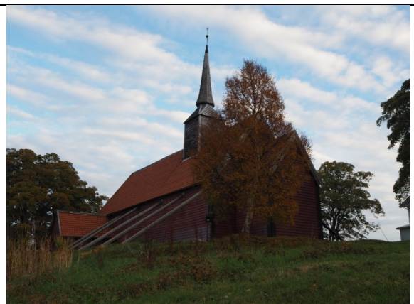
Kirkens nord- og vestfasade og skråstøtter på nordveggen.
