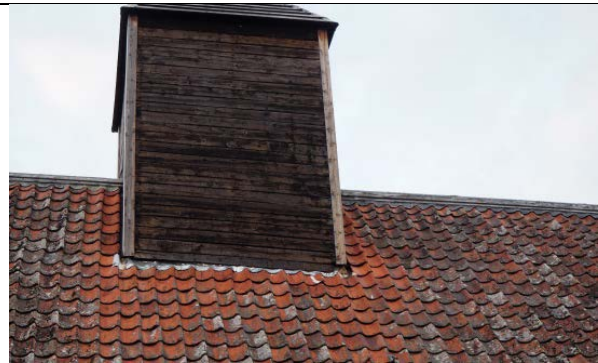
Overgang mellom takrytter og tak.
