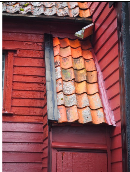
Taket over inngangen til prestesolen på vestdelen av stdvæggen. Innbygget gradrenne. Nedre del av panelet er nymalt.
