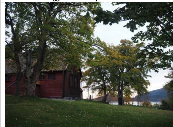
Kirkens sydvegg, østre del med kor-inngang.
