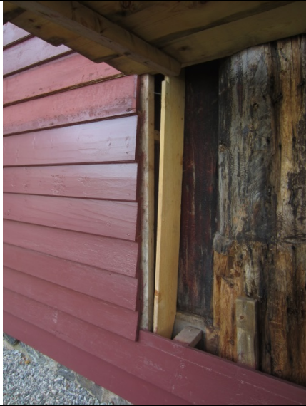
Inspeksjonsluke med stavkonstruksjon. Nordfasade.
