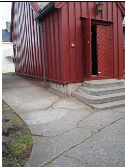
Nedløpsrør leder vannet ned i støpt renne og videre ut på gata.
