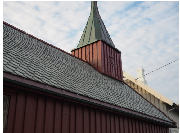
Nordre takfall av kirka. Under stavkirkeprogrammet ble det påvist råteskader i takryttere og tårn. Råteskadet material ble erstattet og tårnet fikk ny kobberkledning.
