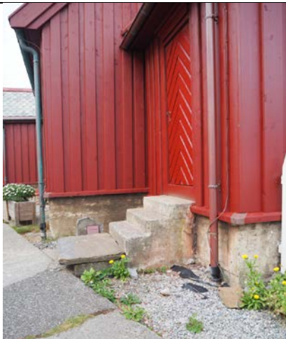
Sørsida av sakristia. Nedløpsrøren er påkopleet et system for lede unna regnvann, men singel langs med grunnmuren forbedrer dreneringen.
