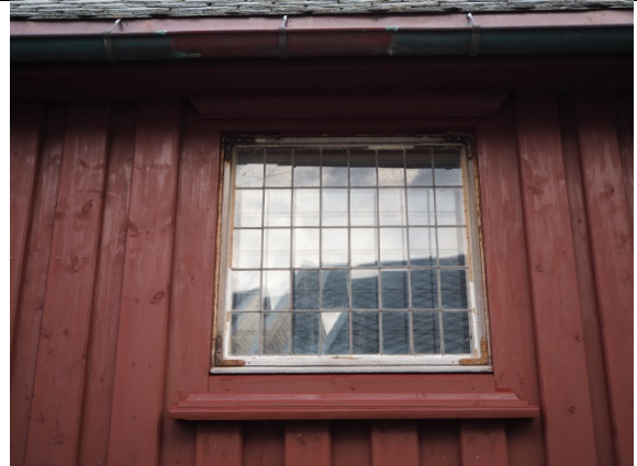
Blyinnfattet vinduer på sørsida. Vinduet er fra restaureringen på 1930-tallet
