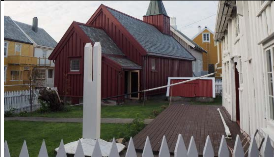
En interessant løsning for å redusere vannbelastning på Grip stavkirke. Nabobygningens nedløpsrør fører vannet forbi kirka og ned i en oppsamlingsgrøft .
