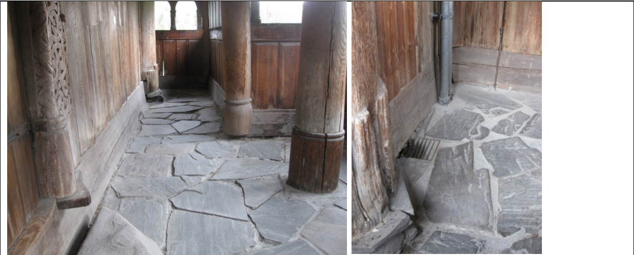
Omgangene har et dreneringssystem som bør overvåkes.
