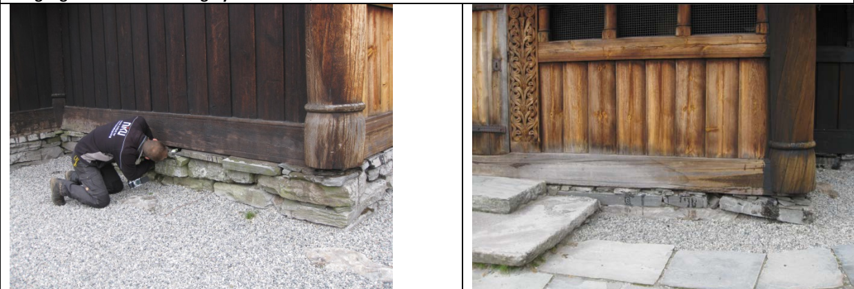
Omgangene har et dreneringssystem som bør overvåkes.
