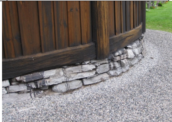
Detalj bilde av grunnmur.
