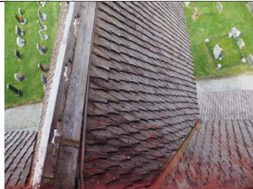
Mønerytter, spontak med linoljestenk fra tårnet, og vinkelrenne.
