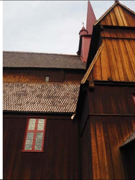
Tak og fasade på korsarm og skip sett fra syd. Sideveggen i det hevede midtrommet er kledd i spon.
