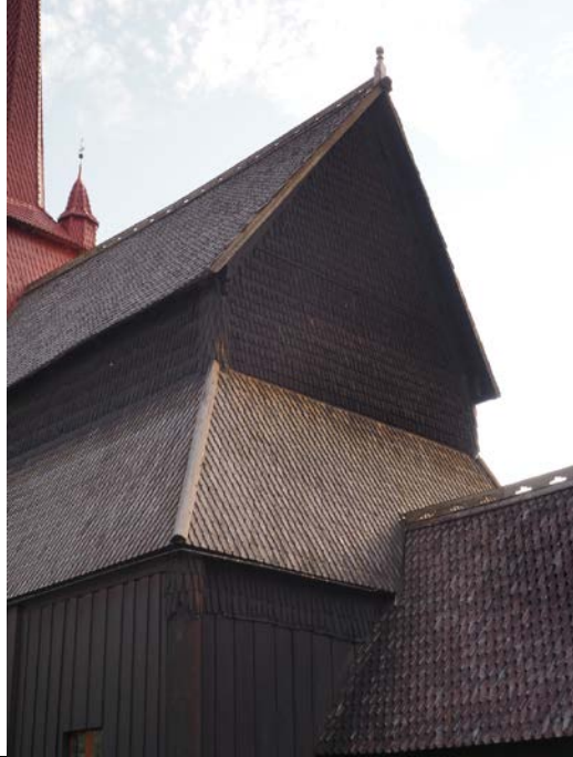
Tak, gavl og sidevegger i det hevede midtrommet er alle kledd med spon.
