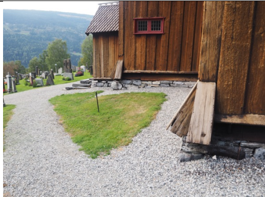
Bildet viser korets sydøstlige hjørne, grusgang og fall ut fra kirkebygget. Legg merke til løsningen med skråstilte bord over svillenes avslutning.
