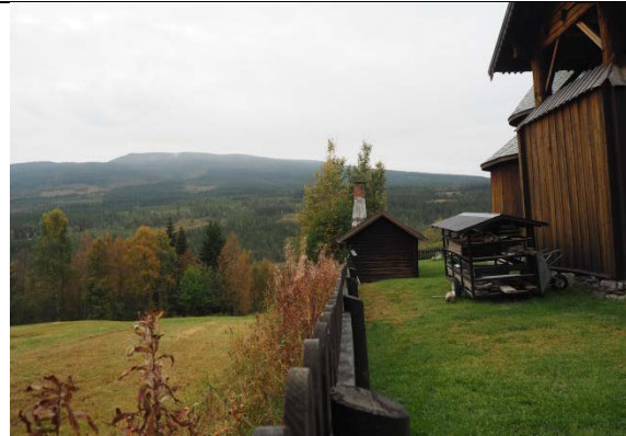
Støpul og ytterste delen av apsiden til høyre i bilde. Til venstre om stakittet er en nivåforskjell i forhold til jordet utenfor.
