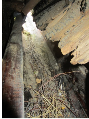
Takrenne i tre som går gjennom loft over sakristi. Den kan inspiseres ved å kripe opp gjennom luke i taket. Se bilde til venstre hvor Haugen, NIKU, inspiserer etter tillatelse fra kirkevergen.
