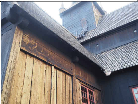
Deler av vestre yttervegg på nordre korsarm samt gradrenne og trapp fra luke opp till tårnet.
