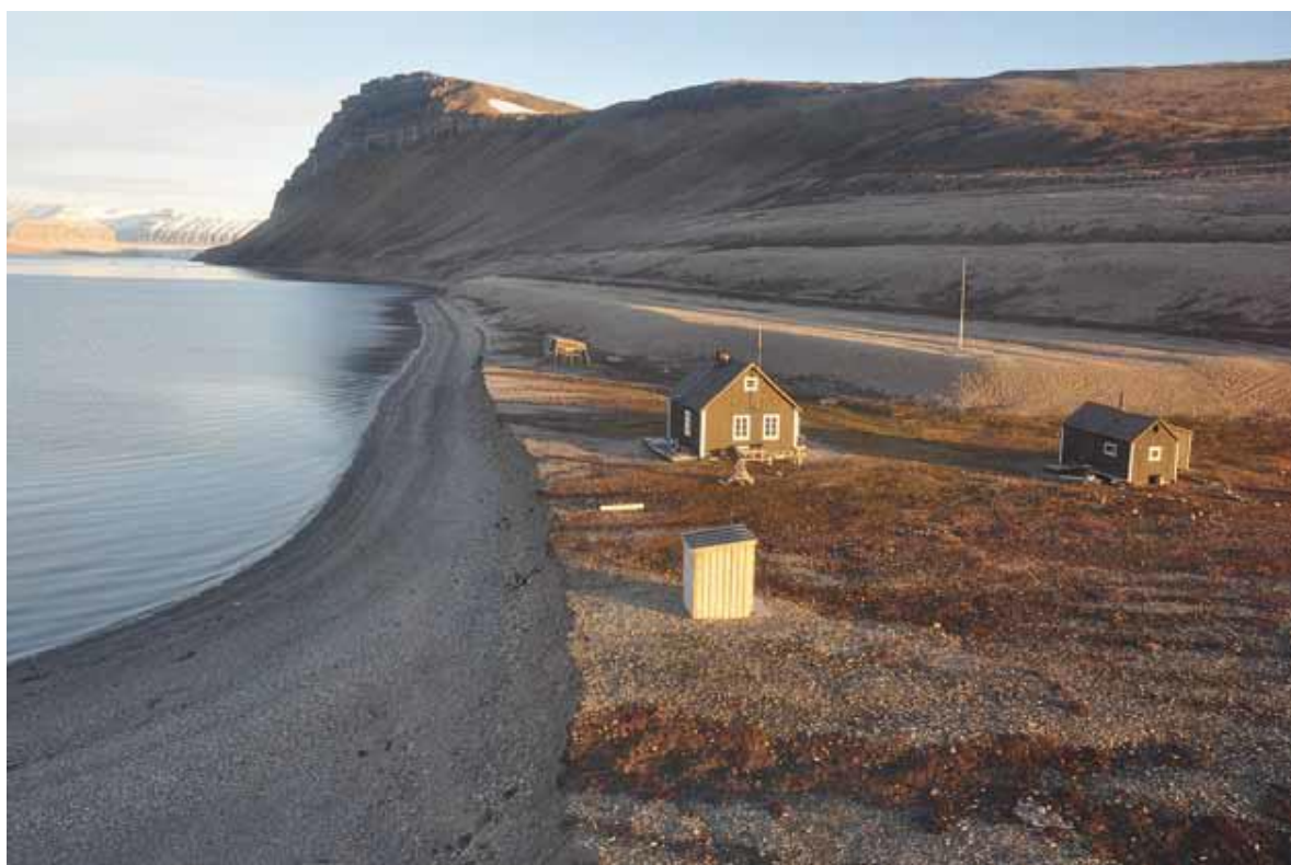
Fredheim høsten 2012 Foto som viser hvordan endring av erosjonskanten kan true bygningsarven på Svalbard. På grunn av den økende kysterosjonen ble hele fangststasjonen våren 2015 flyttet til terrassen som en ser bak flaggstanga.
