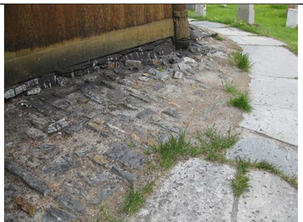
Hellegang rundt kirken: Sørøst – terrenget heller vekk fra kirken
