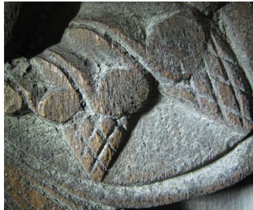
Vestportalen. Søylene og deler av ornamentene i nå-høyde er slitt.
