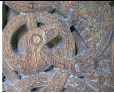
Vestportalen. Søylene og deler av ornamentene i nå-høyde er slitt.
