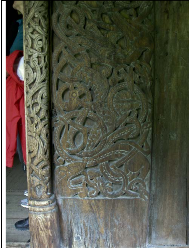
Vestportalen. Søylene og deler av ornamentene i nå-høyde er slitt.
