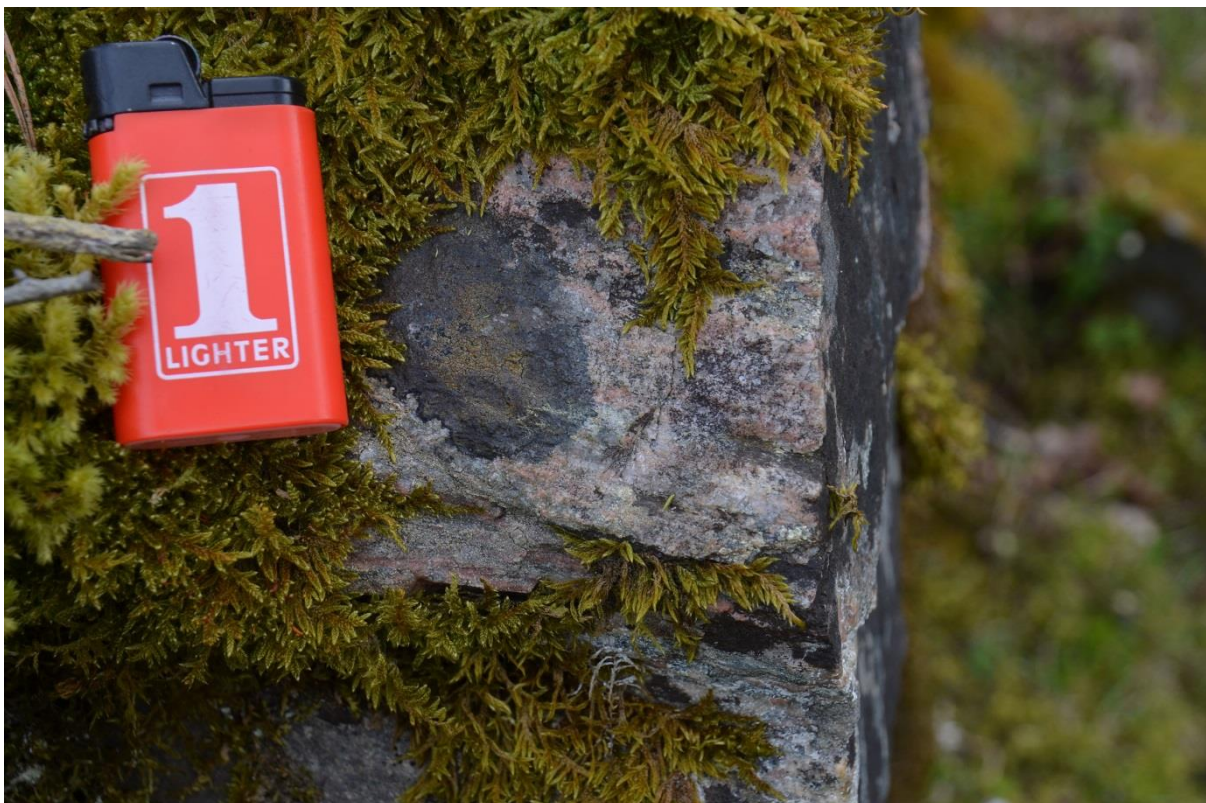
Figur 26: En annen blokk i murverket på Valdisholm: Gneis av granittisk type.
