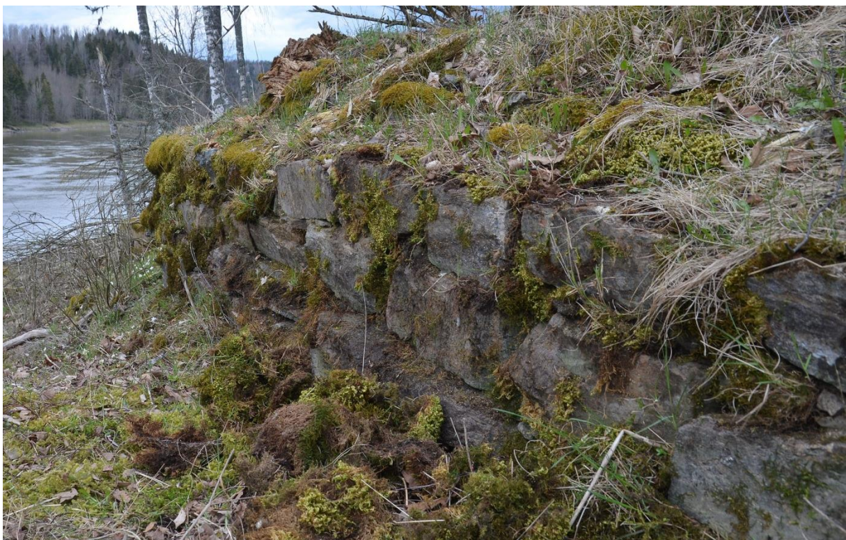
Figur 24: Den bevarte vestmuren på Valdisholm etter delvis rensning (av mose). Her er det mye amfibolitt, men også gneis i de tuktede, ganske så rektangulære blokkene.
