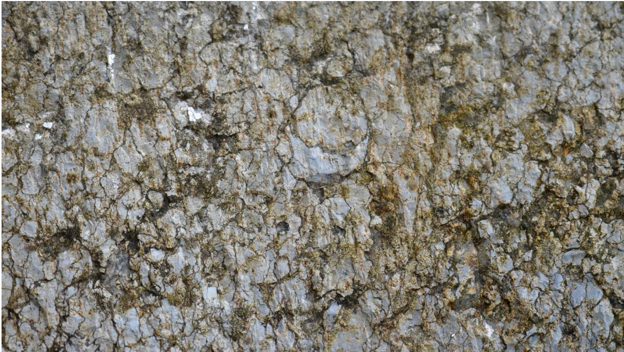
Figur 11: Orthocerkalk på Ringsaker kirke. Store deler av kirken er kalkpusset; dette bildet ble tatt i et lite, upusset område på nordsiden av kirken. Det skulle ikke forundre om den sirkulære strukturen midt på bildet er tverrsnittet på en orthoceras, en blekksprut fra ordovicium.
