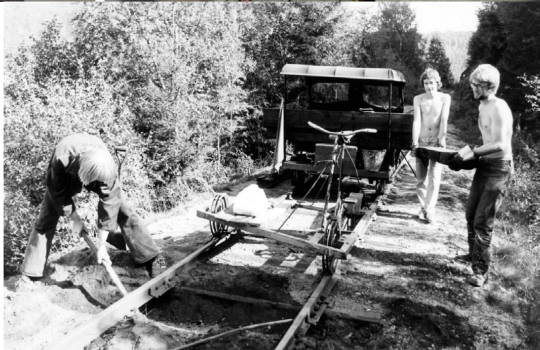
Carl Frederik Thorsager, Morten Tranøy og Bernt Havre skifter sviller på Setesdalsbanen i 1972. Thorsager til høyre og Tranøy bakerst/i midten bærende på en sville. Foto: Svein Erik Larsen
