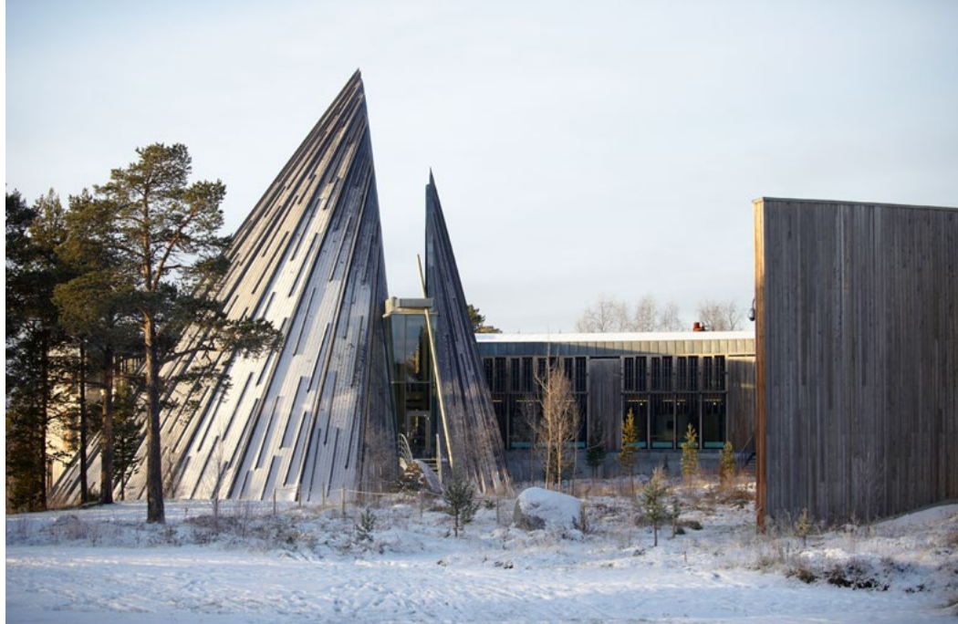
Sametingsbygningen i Karasjok ble åpnet i 2000 og er tegnet av sivilarkitektene Stein Halvorsen og Christian Sundby. Foto: Denis Caviglia, Sámediggi/Sametinget
