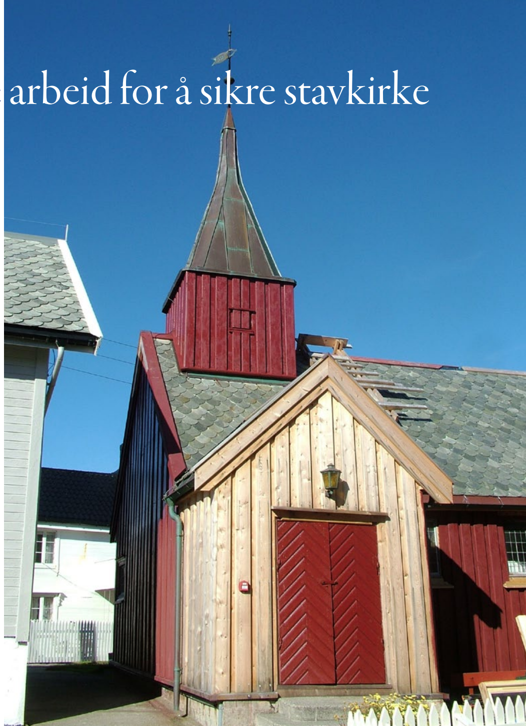
Panelet på Grip stavkirke ble i sin helhet skiftet for å øke brannmotstanden. Det erstattet et panel fra 1930-tallet, men det ble ikke gjort endringer eller andre bygningsmessige tiltak i stavkirkekonstruksjonen. Bildet viser Grip stavkirke med ny panel. Foto: Rolf Lervik
