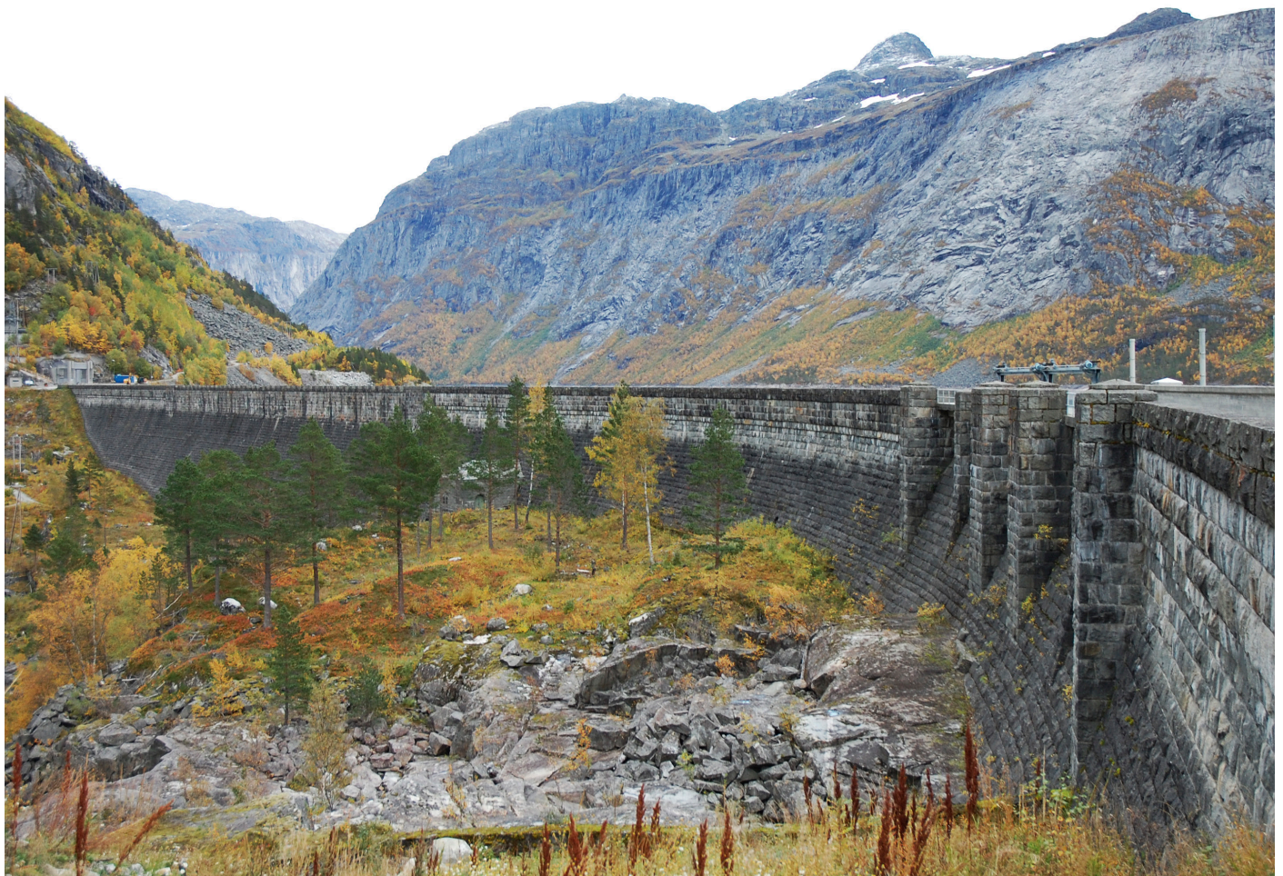
Ringedalsdammen var mellom dei største gravitasjonsdammene i verda då den sto ferdig i 1918. Den held vassmagasinet som gjev kraft til industrisamfunnet ved fjorden. Foto: David Aasen Sandved, Hordaland fylkeskommune.
