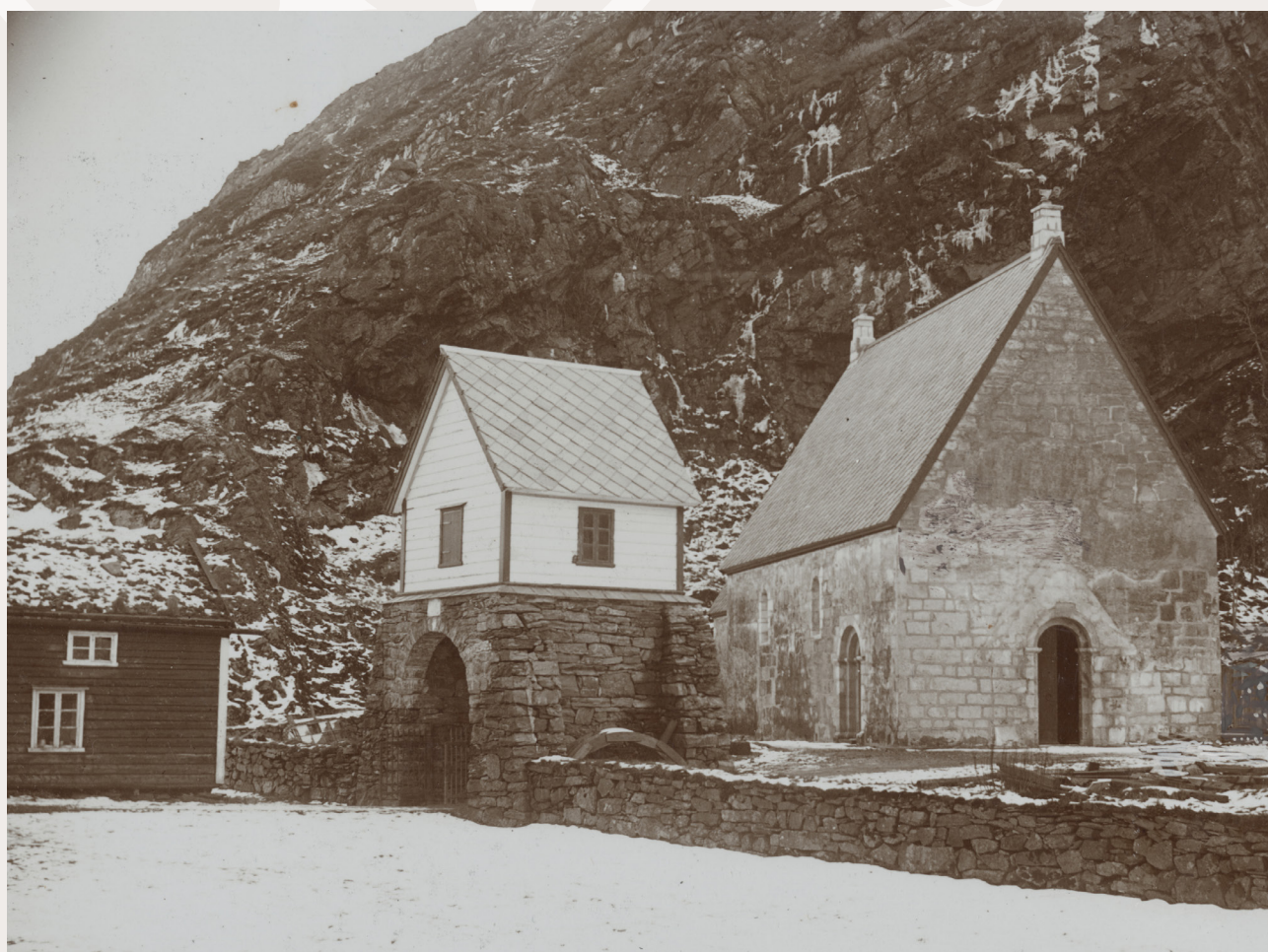
Kinn kirke ca 1900-1910, Flora kommune. Foto: Riksantikvaren, ukjent fotograf.
