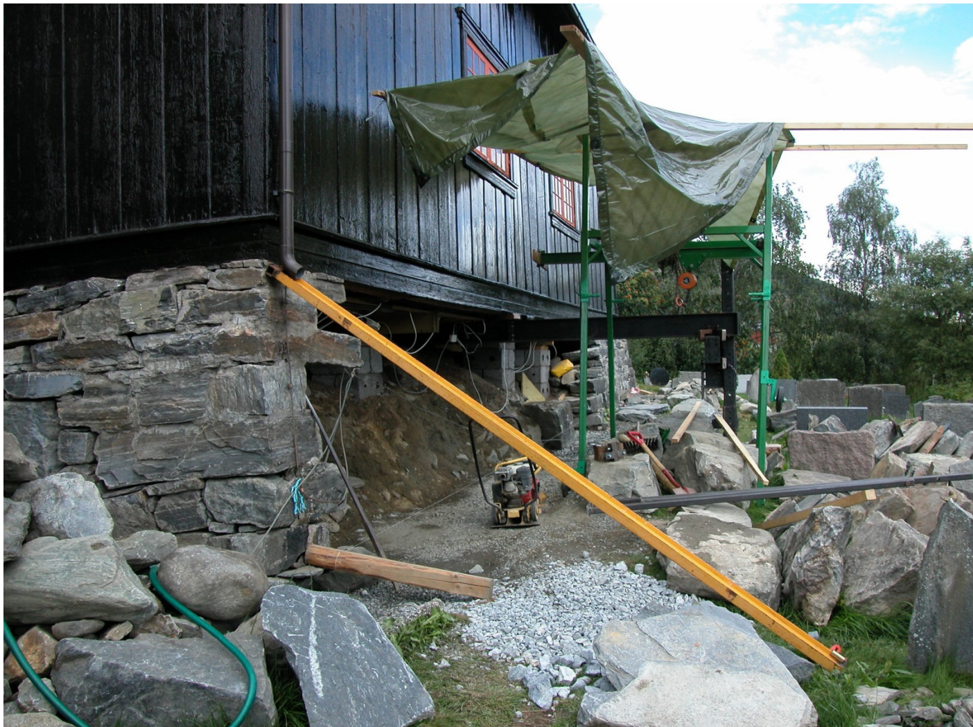
Grunnmur: Omfattande utbetring av fundament og grunnmur under sydsida av kyrkja. Foto: Ellen M. Devold. Riksantikvarens arkiv.
