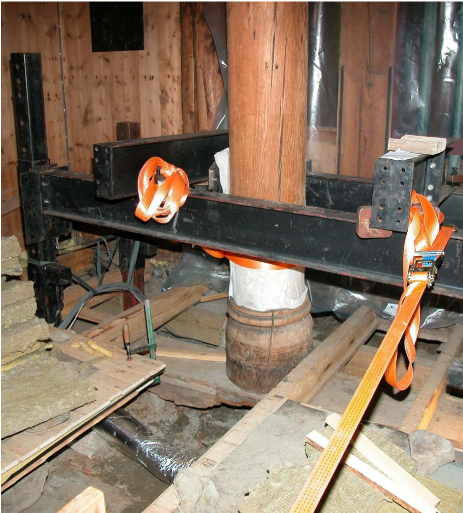
Jekking: Heving av stav for utbetring av røteskade. Foto Ellen M. Devold, Riksantikvarens arkiv.
