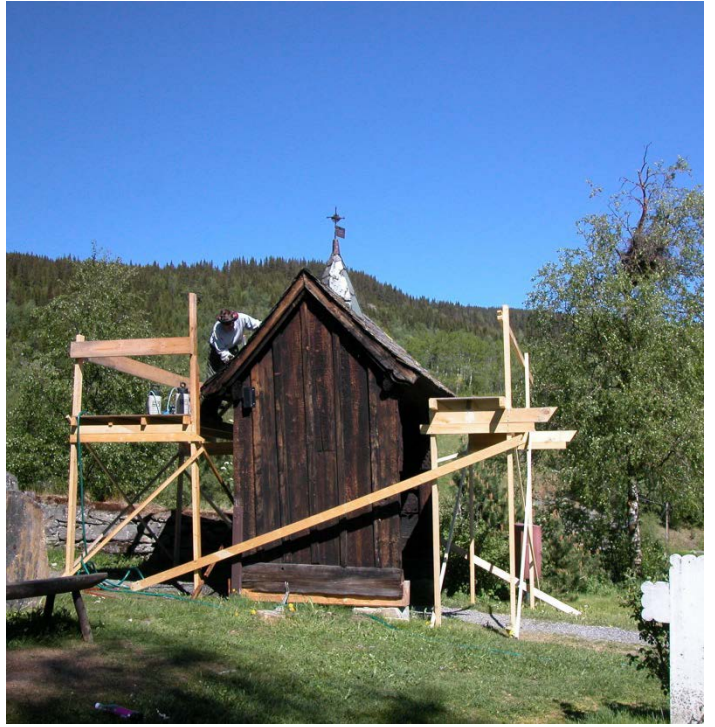
Portal: Reparasjon av taket på inngangsportalen som har fått ny svill etter røte og stokkmaurangrep. Foto: Ananke Sajdak, Riksantikvarens arkiv.
