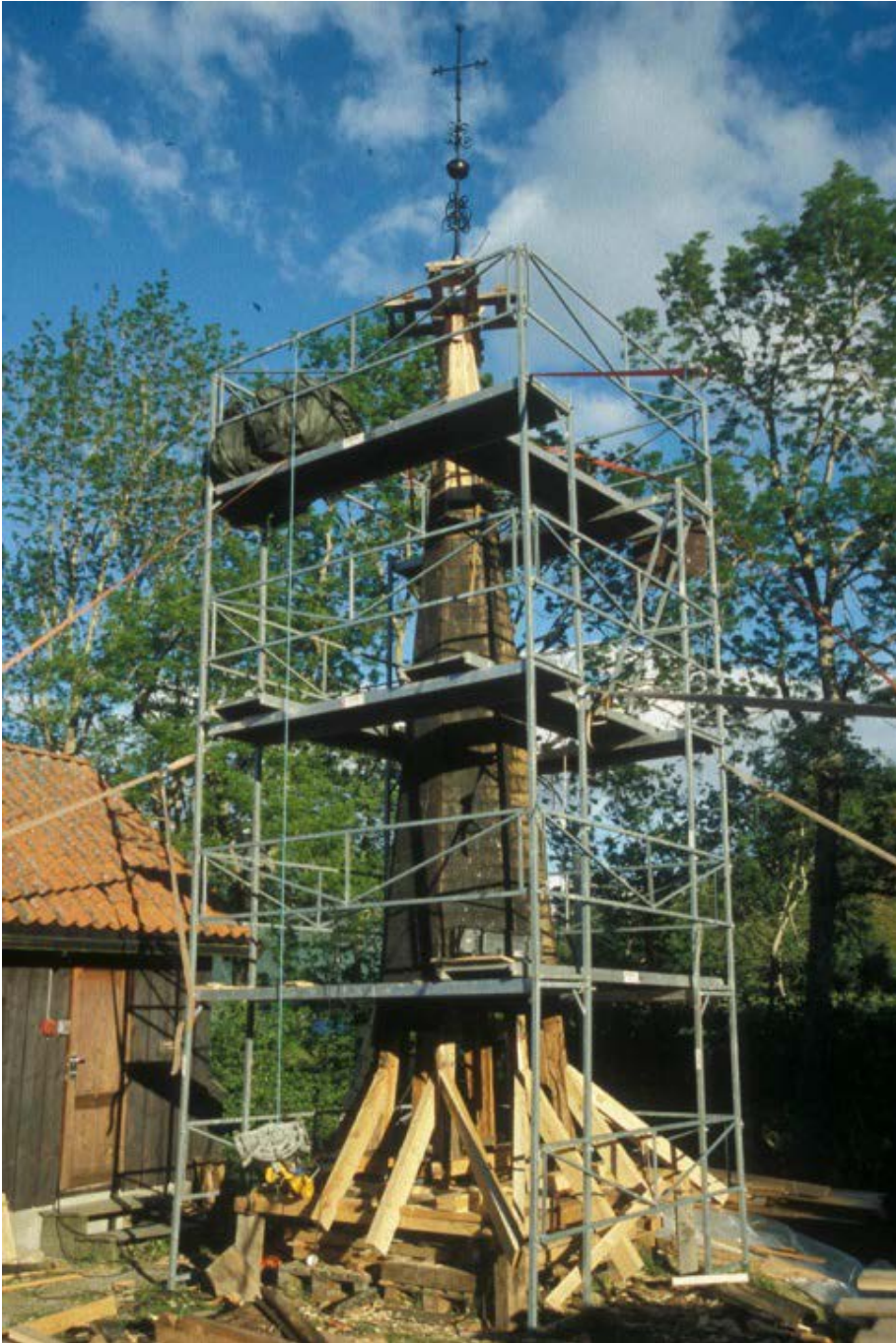
Istandsetting: Utbetring av tårnet. Foto: Berge Hjørungnes, Riksantikvarens arkiv.
