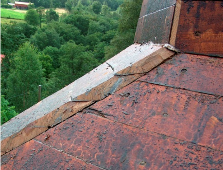
Tjærebreidd: Overflata av takryttaren vart behandla med tjære. Foto: Berge Hjørungnes, Riksantikvarens arkiv.
