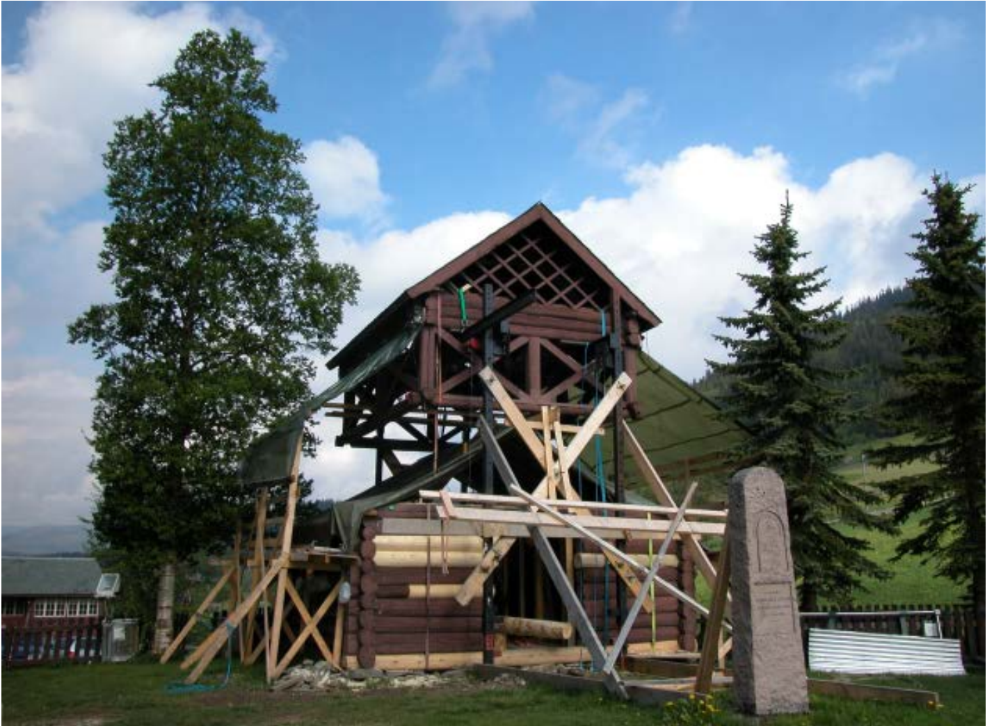
Lyft: Støpulen under istandsettingsarbeidet. Foto: Ellen M. Devold / Riksantikvarens arkiv.
