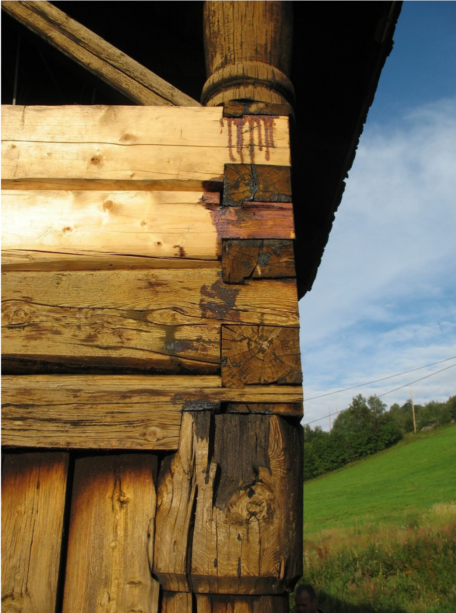
Kyrkjegardsporten: Utsifting av røteskadde bygningsdelar. Foto: Flavio Carniel, Riksantikvarens arkiv.
