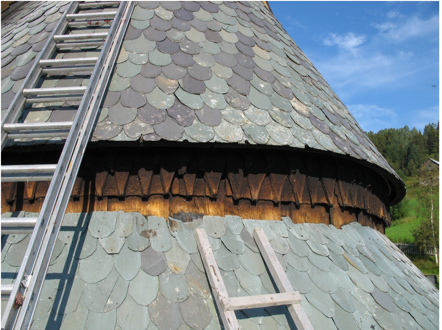
Apsid: Reingjort og utbetra takflate. Foto: Flavio Carniel, Riksantikvarens arkiv.
