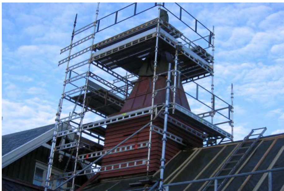
Spir: Spiret var svært røteskadd og forbindelsen mellom midtmast og spuns fra 70-talet var svekka. Masta til spiret vart spunsa, og røteskadd virke erstatta. Foto: Ola Storsletten.
