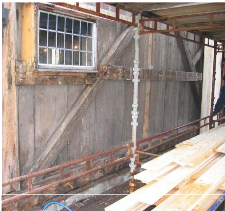
før ny rupanel og kledning vart montert. Skråstivaren er truleg opphavleg. Foto: Ola Storsletten.
