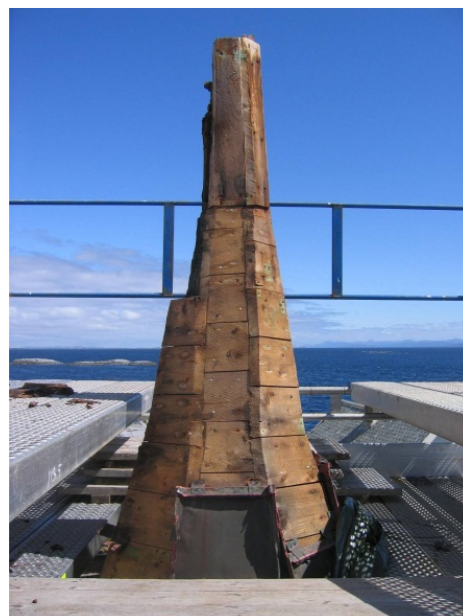
Spir: Spiret var svært røteskadd og forbindelsen mellom midtmast og spuns fra 70-talet var svekka. Masta til spiret vart spunsa, og røteskadd virke erstatta. Foto: Ola Storsletten.
