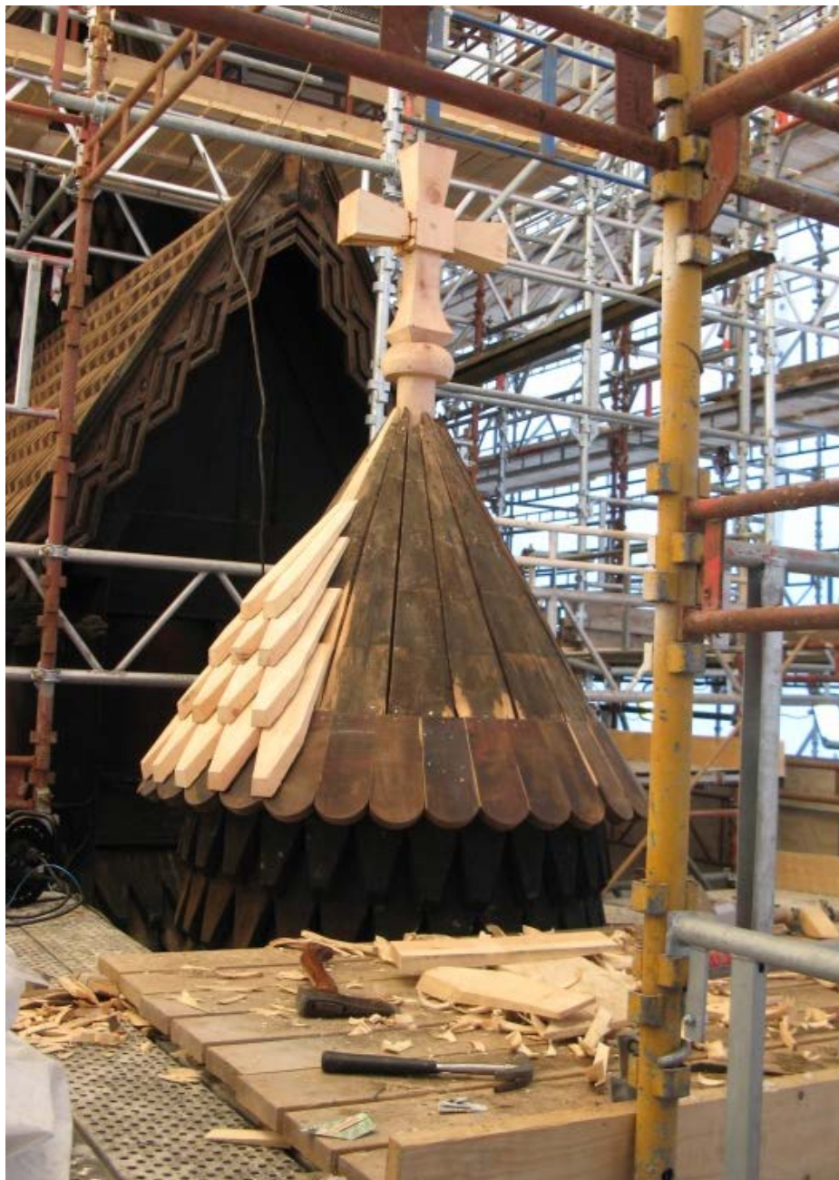
Spontekking: Montering av spon på Gol stavkyrkje. Foto: Sjur Mehlum. Riksantikvarens arkiv.
