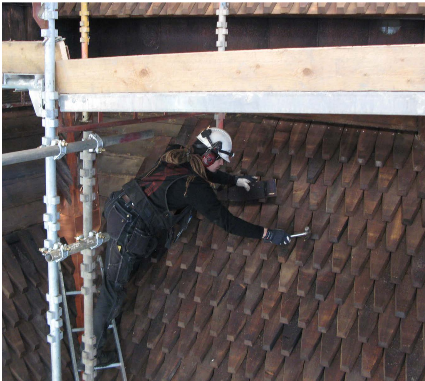
Spontekking: Montering av spon på Gol stavkyrkje. Foto: Sjur Mehlum. Riksantikvarens arkiv.
