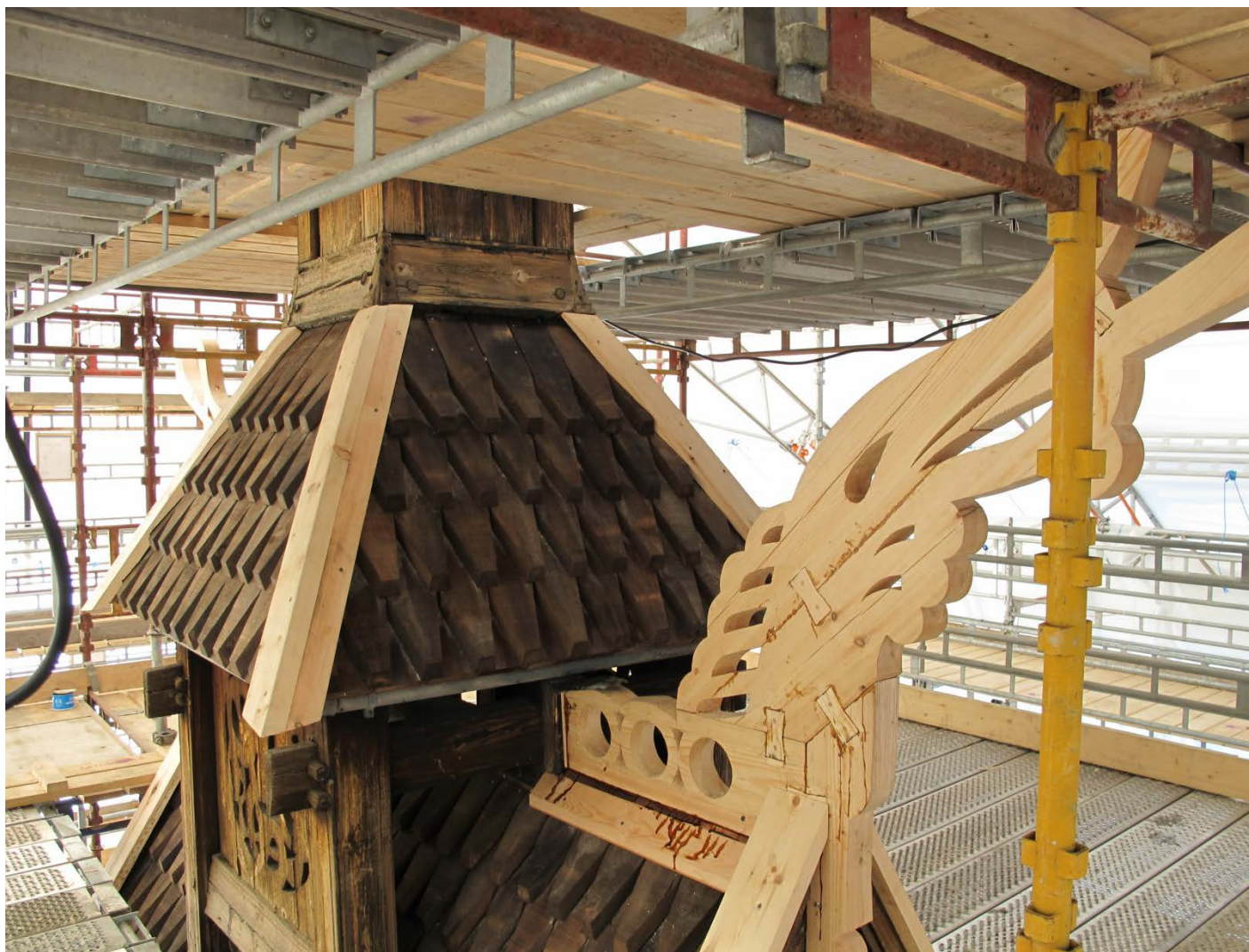
Dragehovud: Det vart montert nye kopiar av dragehovuda ved takryttaren på kyrkja . Foto: Gunvor Haustveit. Riksantikvarens arkiv.
