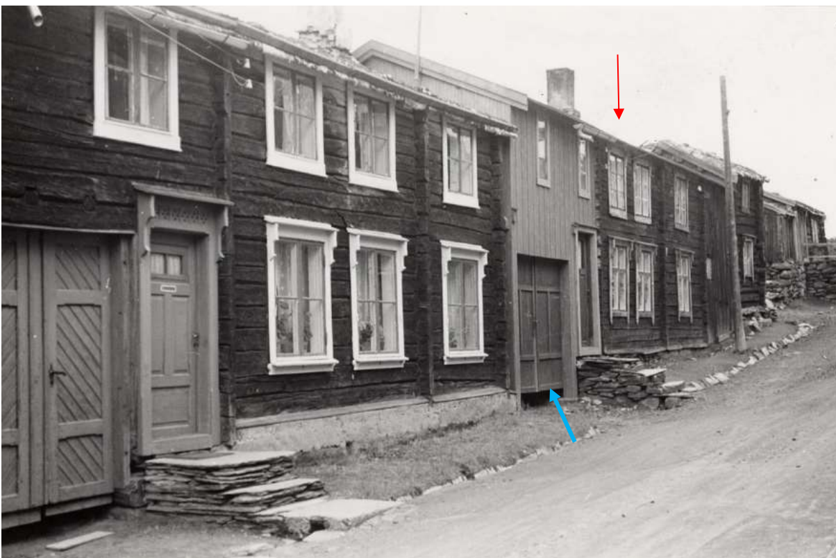
Figur 8. Røros. Sleggveien. Nr.8. (Rød pil). Fotograf Halvor Vreim. 1. juli 1958. Bildet er sikkert tatt da Vreim var på befarings for blant annet å foreslå utskifting av panel, vinduer og dør på Sleggveien 8. Den opprinnelige porten står fremdeles på plass. Blå pil. Riksantikvarens arkiv.
