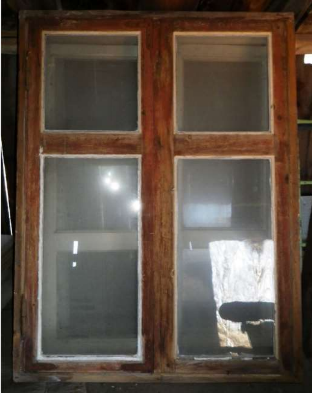
Figur 20. Røros. Sleggveien 8. Et av vinduene fra 1905-1910 i 1. etasje. Foto: J. Brønne. 2016.
