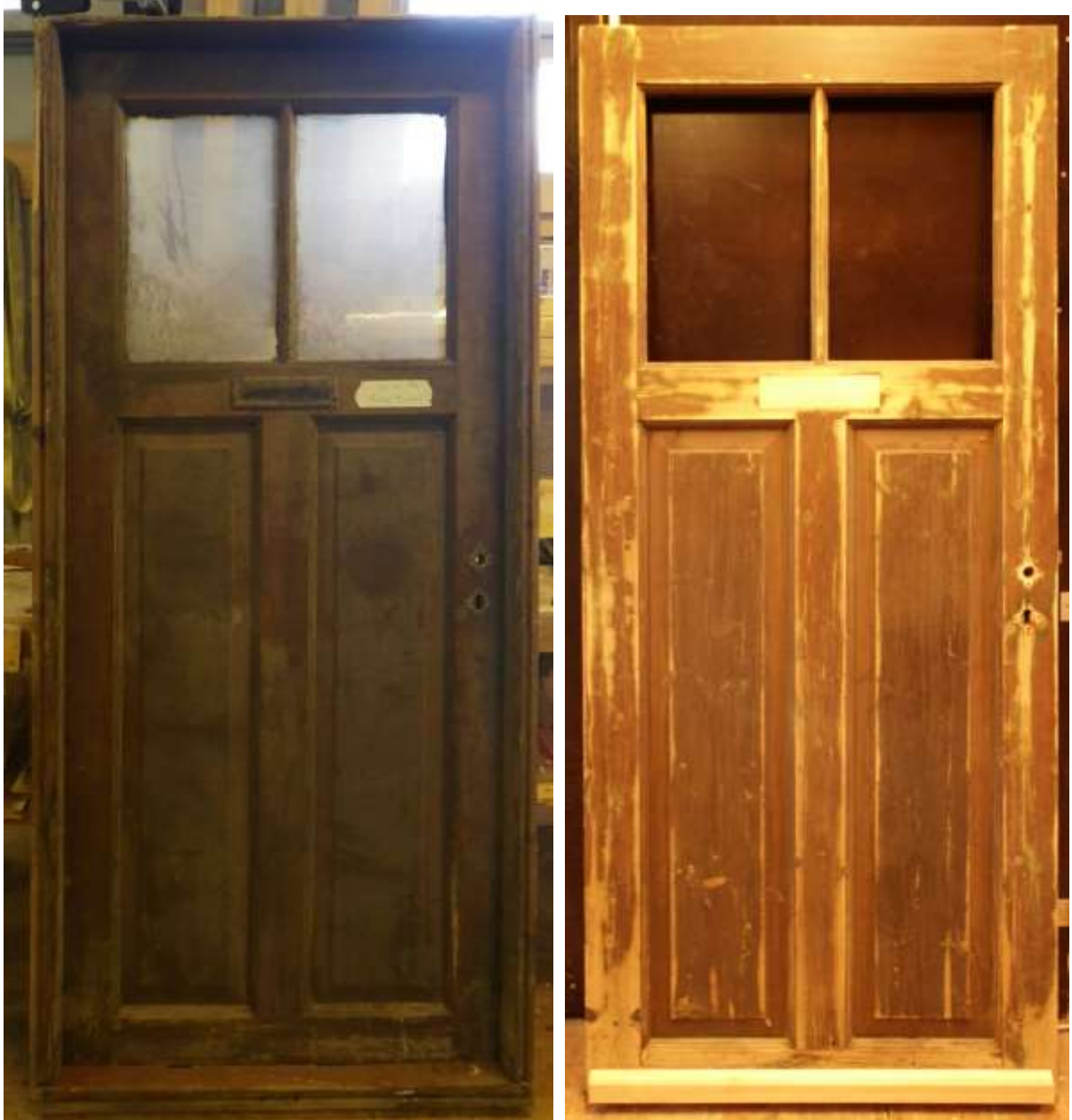
Figur 18. Røros. Sleggveien 8. Opprinnelig hoveddør fra ca. 1870. Før restaurering til venstre, og under restaurering på Antikvarisk verksted til høyre. Foto: J. Brønne. 2016.
