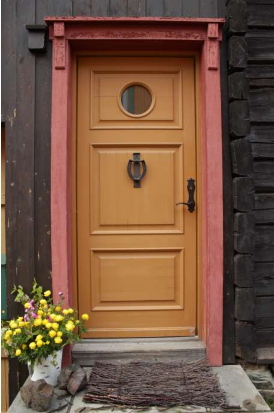
Figur 11. Røros. Sleggveien 8. Hoveddøra fra 1999-2000. Foto: J. Brønne. 2016.
