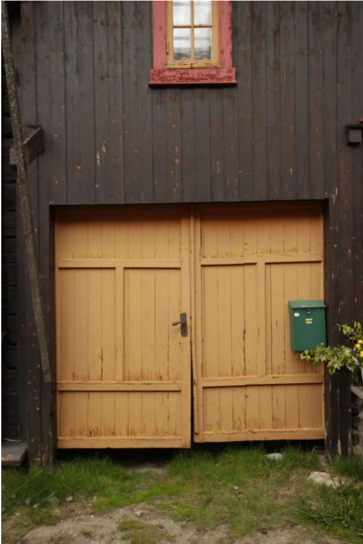
Figur 15. Røros. Sleggveien 8. Porten fra 1959. Foto: J. Brønne. 2016.
