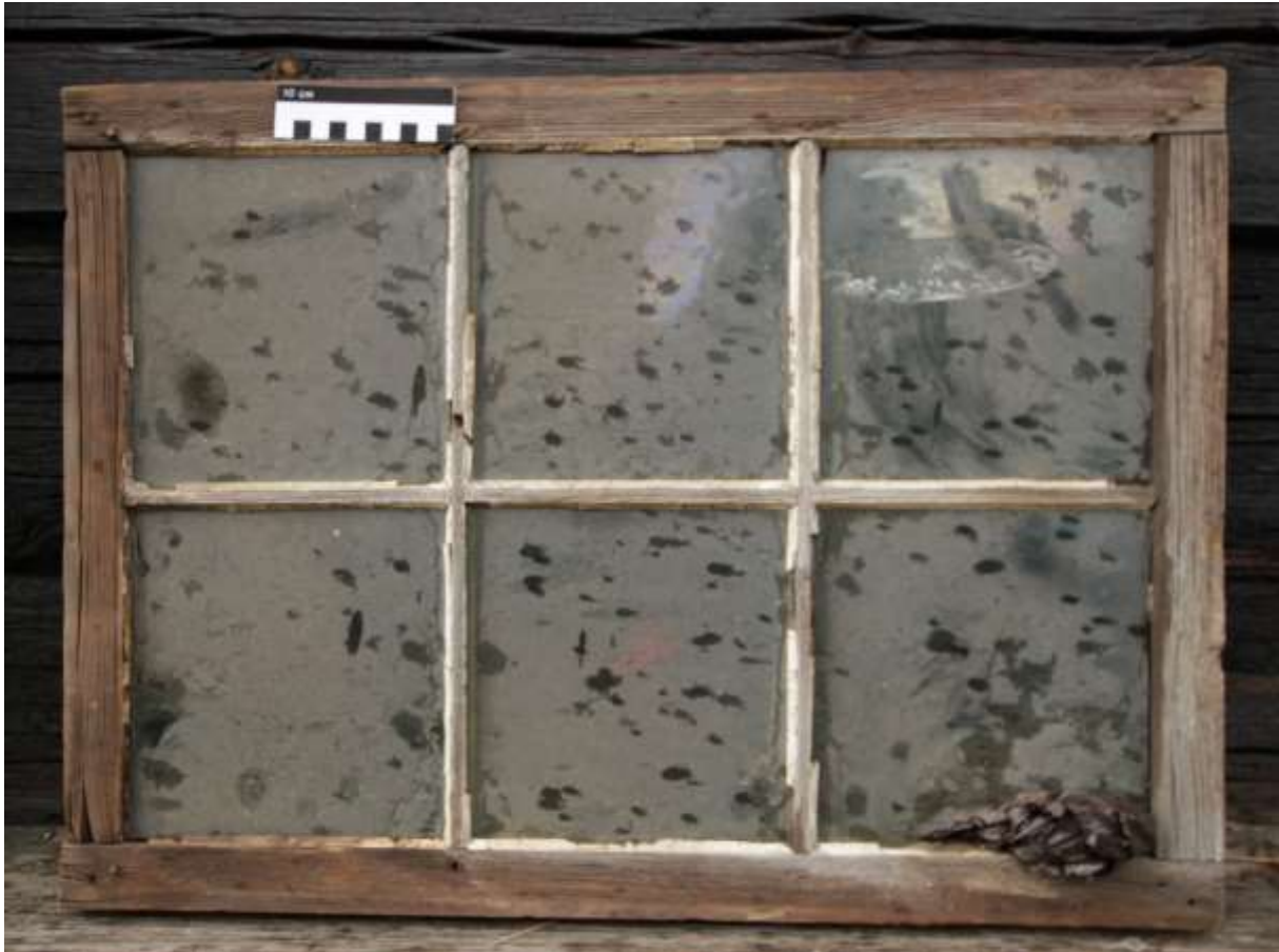
Figur 21. Røros. Sleggveien 8. Det opprinnelige vinduet i tilbygget mot nord. (Se også figurene 6 og 7) Foto: J. Brønne. 2016.
