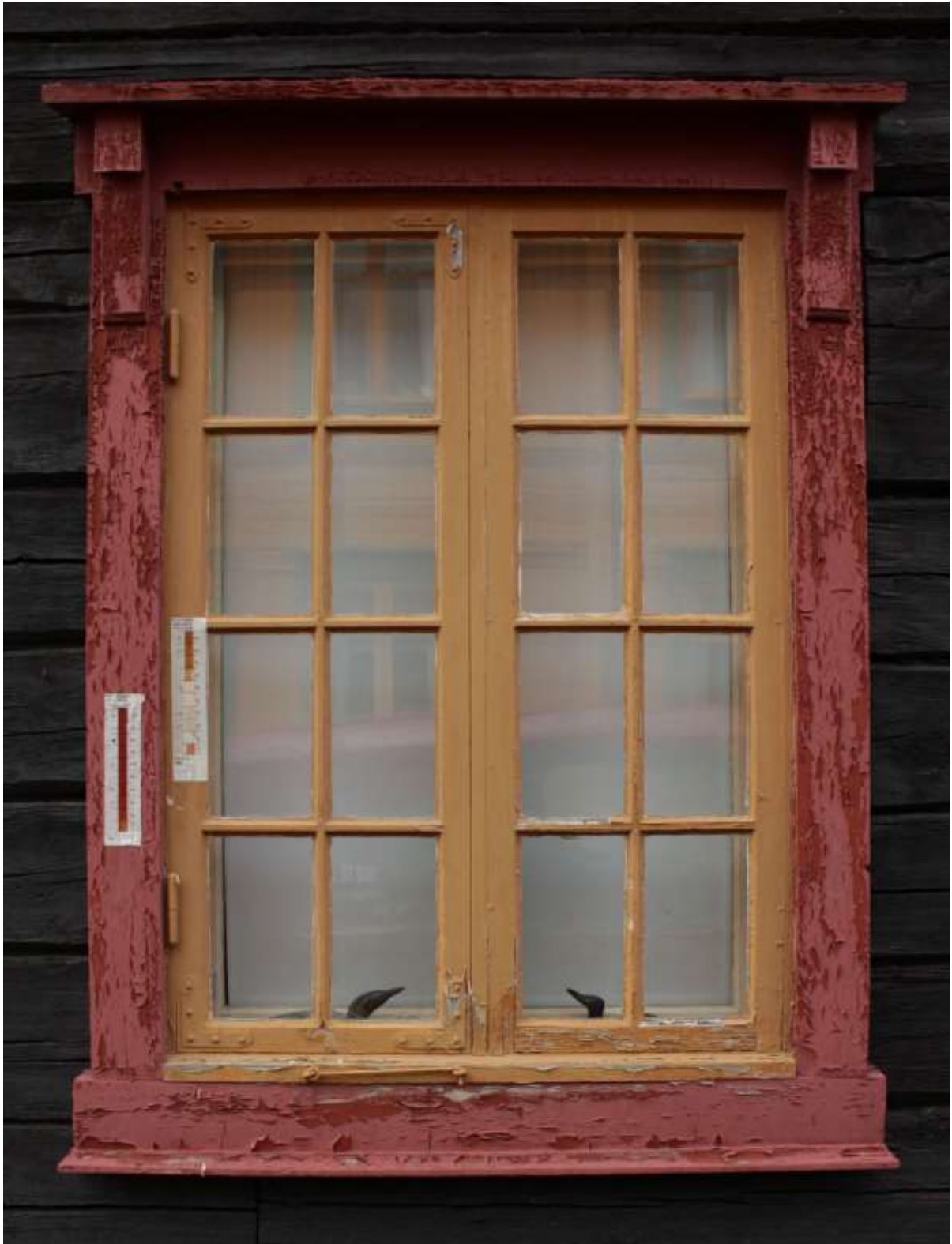
Figur 12. Røros. Sleggveien 8. Vindu med gerikter i 1. etasje fra 1959. Foto: J. Brænne. 2016.
