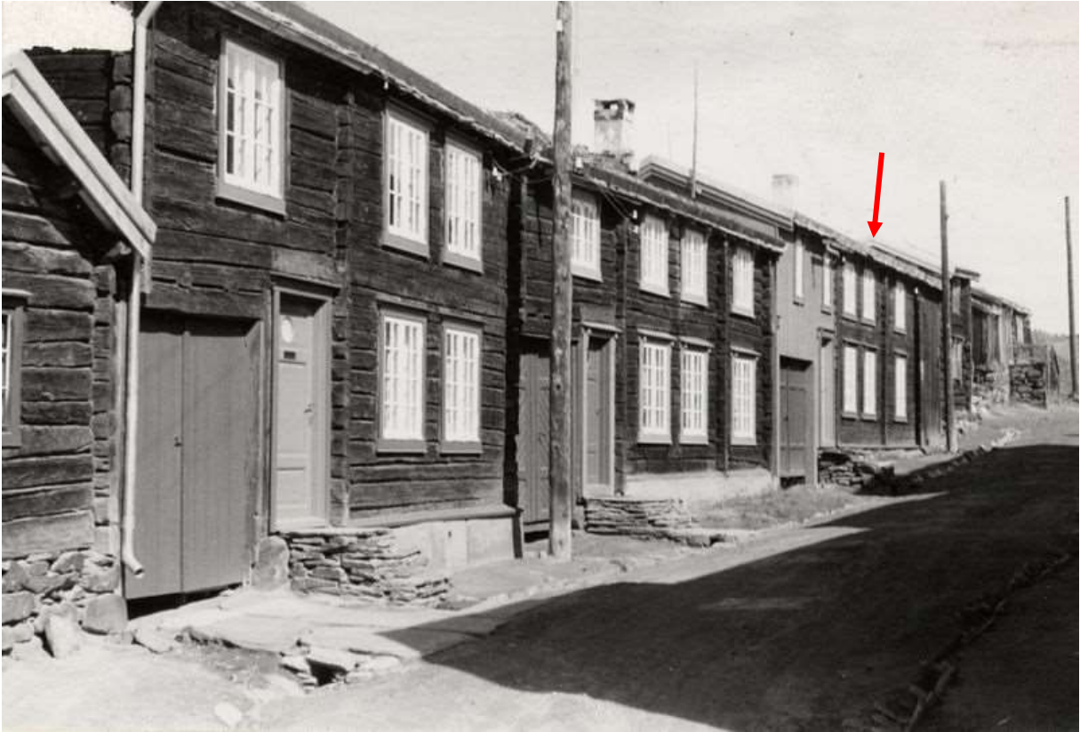
Figur 9. Røros. Sleggveien 8. 1959. Sleggveien med Nr.8. Rød pil. Fasaden er endret etter arkitekt Halvor Vreims forslag og anvisninger. (Se vedlegg) Foto: Ukjent, trolig Halvor Vreim, Riksantikvaren.
