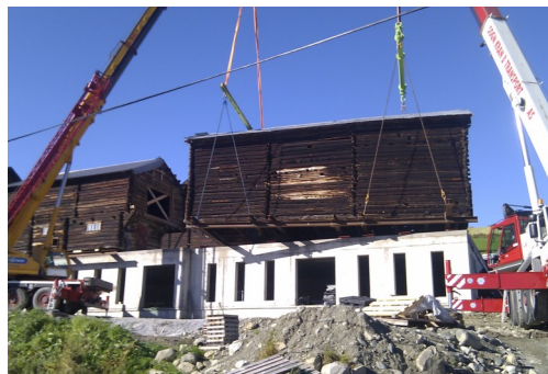
To kraner løfter de to tømmerlåvene fra midlertidlig oppstillingsplass til dekket over nytt sauefjøs. Foto: Renate Søndrål
