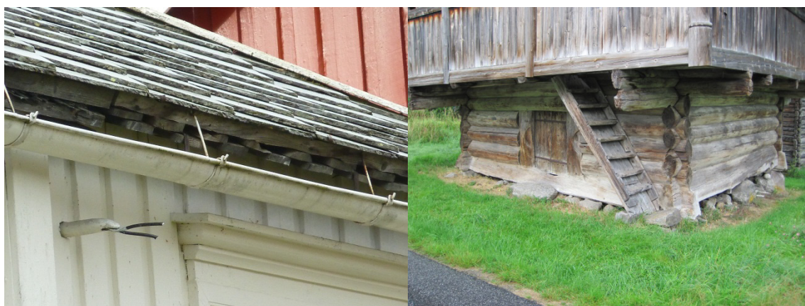
"Detektivarbeid" for registratorar: Skifertaket er ikkje originalt (Melhus), og Findalslaft blei kun bygd før svartedauden (Setesdal). Foto: Sebastian Eiter, Skog og landskap.
