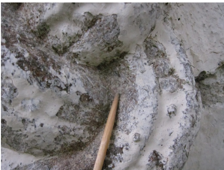
Figur 14: Foto: undersøkelsesområde ved portalens nordre dragehale. Et grålig kalklag er funnet som første lag på steinoverflaten. NIKU 2016
