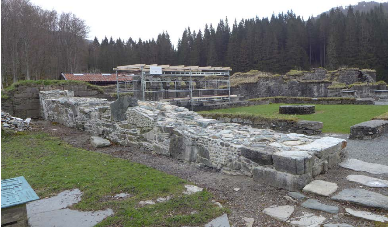
Figur 1. Den ferdig istandsatte vestmuren fotografert mot NØ (Foto: Byantikvaren 2015).
