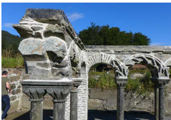
Figur 15. Etter tiltak (Foto: Byantikvaren 2015).
