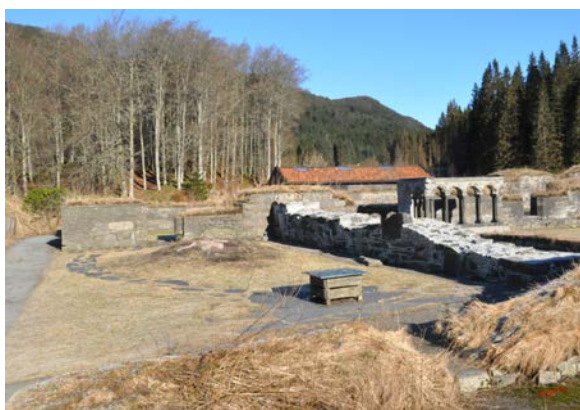
Figur 18. Vestsiden av klosteret etter at trærne ble felt (Foto: Byantikvaren 2016).
