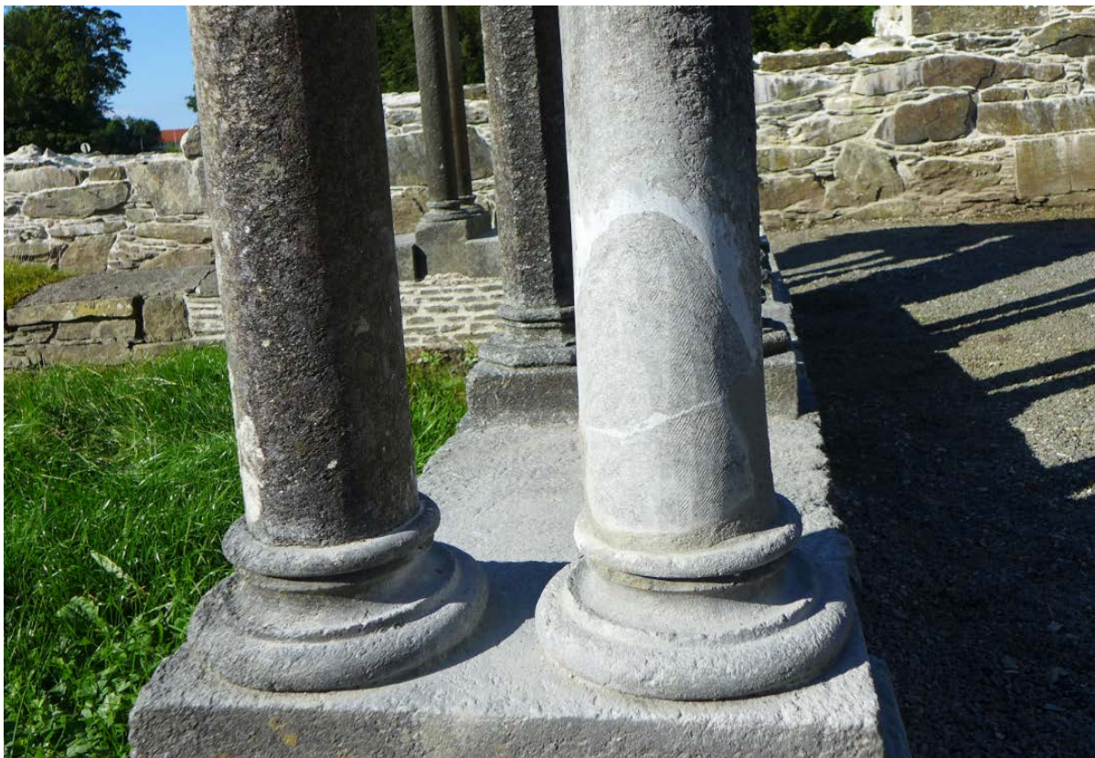
Figur 14. Reparasjon i ett av søyleskaftene (Foto: Byantikvaren 2015).
