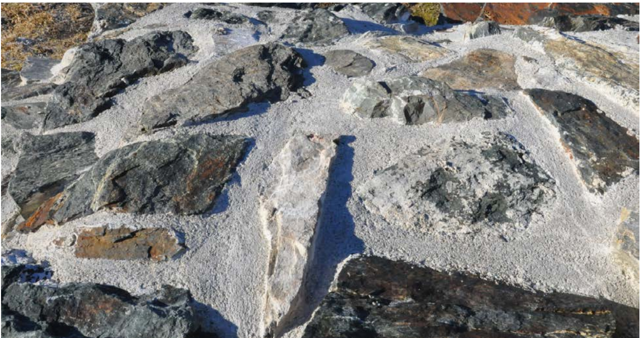
Figur 4. Bildet viser murkronen i vestmuren etter at fugene er skiftet ut og spekket med et grovere sandtilslag i mørtelen (Foto: Byantikvaren 2016).
