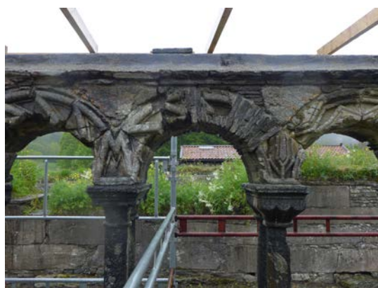
Figur 11. Før tiltak. Detaljbilde av buene fotografert mot nord (Foto: Byantikvaren 2015).
